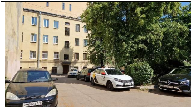
Фото 27. Внутри дворовая территория Объекта оценки
