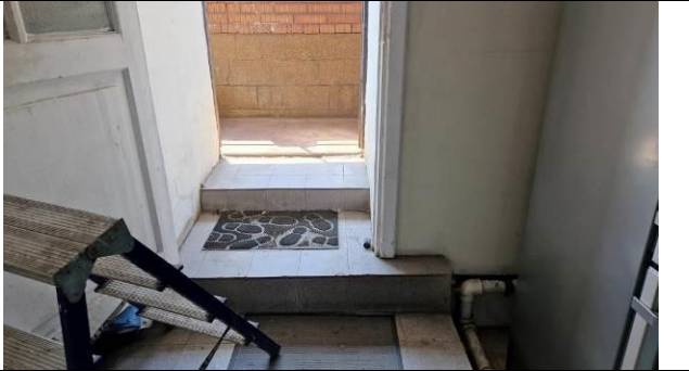
Фото 24. Типичное состояние Объекта оценки
