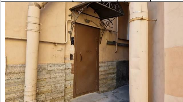
Фото 15. Вход в Объект оценки (общий со двора)
