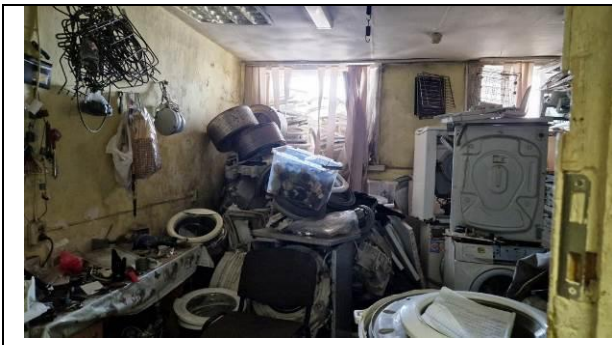
Фото 21. Типичное состояние Объекта оценки
