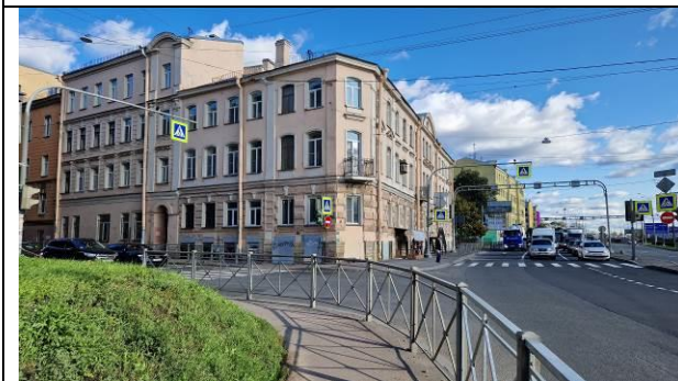
Фото 5. Вид здания расположения Объекта оценки
