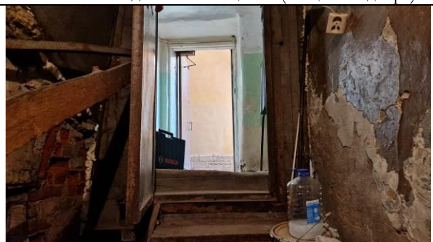
Фото 18. Вход в Объект оценки (общий со двора)
