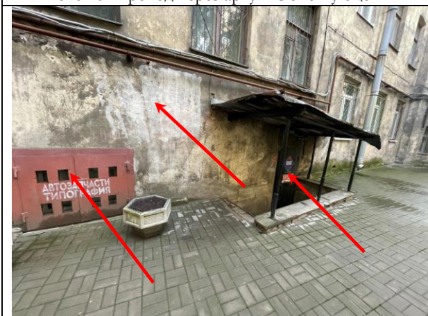
Фото 17. Вид здания расположения Объекта оценки, входная и оконная группа Объекта оценки
