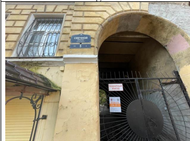
Фото 13. Адрес Объекта оценки
