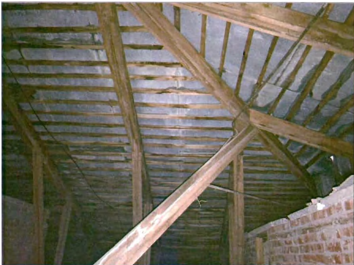
7. Стропильная система. Фрагмент.
