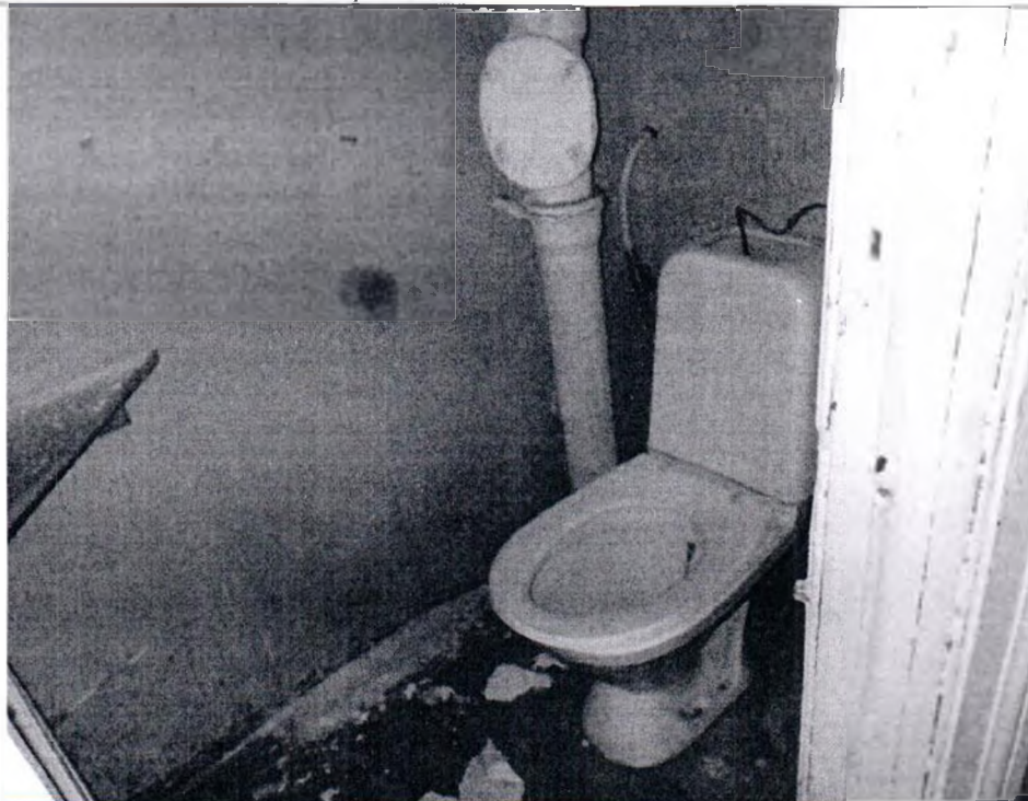
Описание: Вид внутри Объекта (ч.п. 2)
