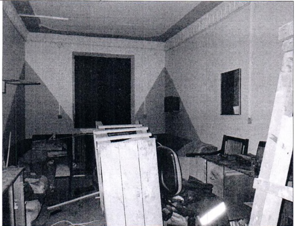
Описание: Вид внутри Объекта (в ч.п. 5 защит оконный проем)
