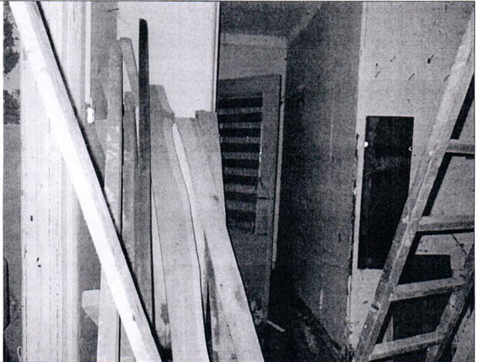
Описание: Вид внутри Объекта (ч.п. 1)
