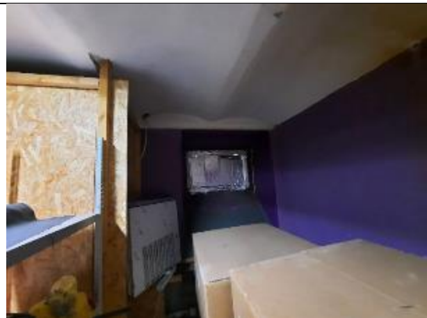
Фото № 24 – Внутреннее состояние помещения
