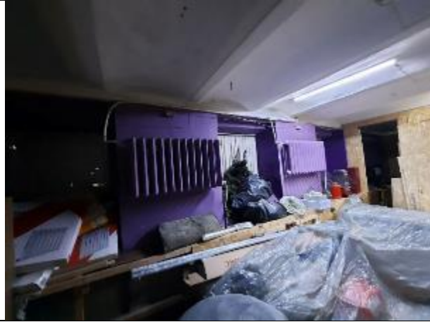
Фото № 17 – Внутреннее состояние помещения
