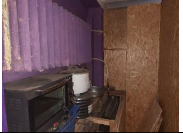
Фото № 18 – Внутреннее состояние помещения
