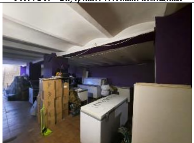
Фото № 12 – Внутреннее состояние помещения
