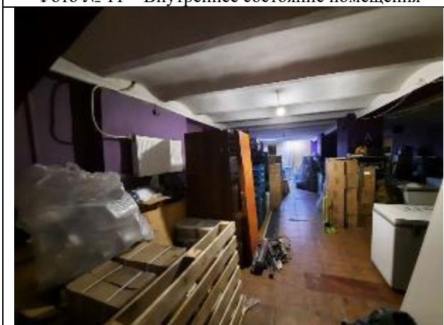
Фото № 13 – Внутреннее состояние помещения
