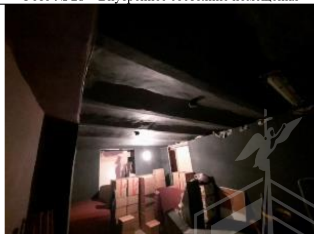
Фото № 30 – Внутреннее состояние помещения
