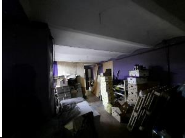
Фото № 15 – Внутреннее состояние помещения
