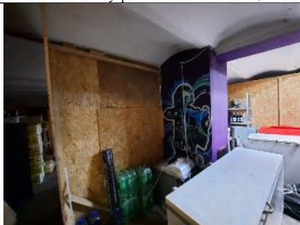
Фото № 21 – Внутреннее состояние помещения
