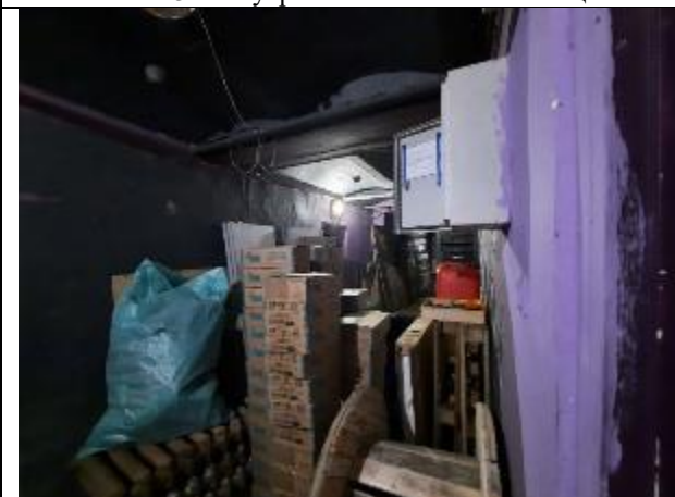
Фото № 25 – Внутреннее состояние помещения
