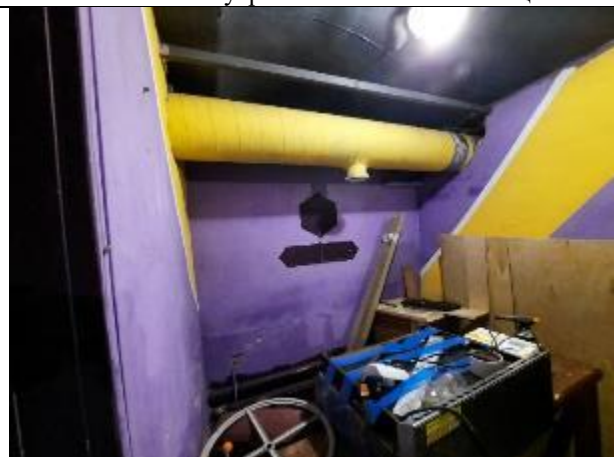
Фото № 26 – Внутреннее состояние помещения
