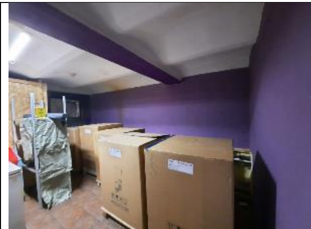
Фото № 23 – Внутреннее состояние помещения
