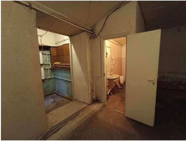
Фото № 19 – Внутреннее состояние помещения
