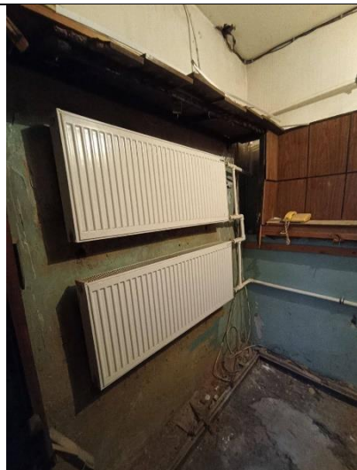
Фото № 8 – Внутреннее состояние помещения
