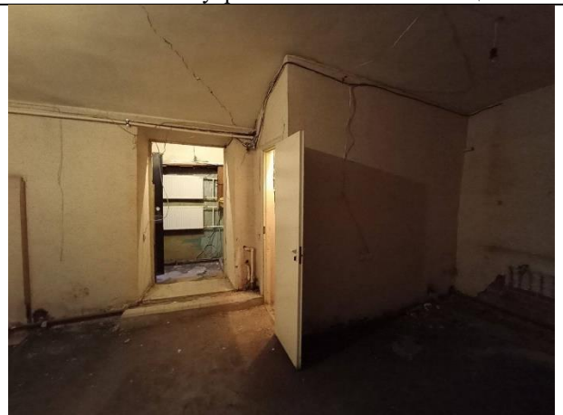
Фото № 18 – Внутреннее состояние помещения
