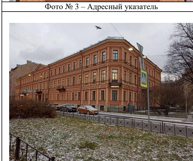
Фото № 5 – Здание, в котором расположен объект оценки
