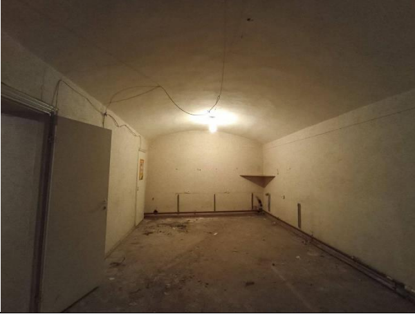
Фото № 15 – Внутреннее состояние помещения
