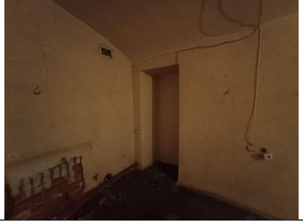
Фото № 16 – Внутреннее состояние помещения
