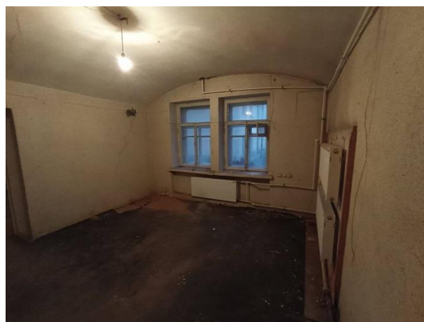
Фото № 10 – Внутреннее состояние помещения
