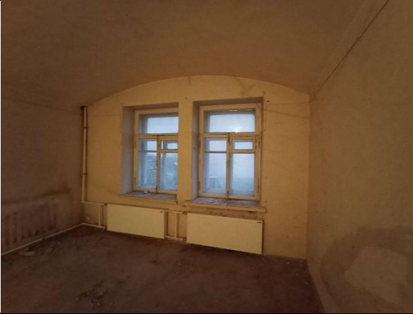
Фото № 13 – Внутреннее состояние помещения
