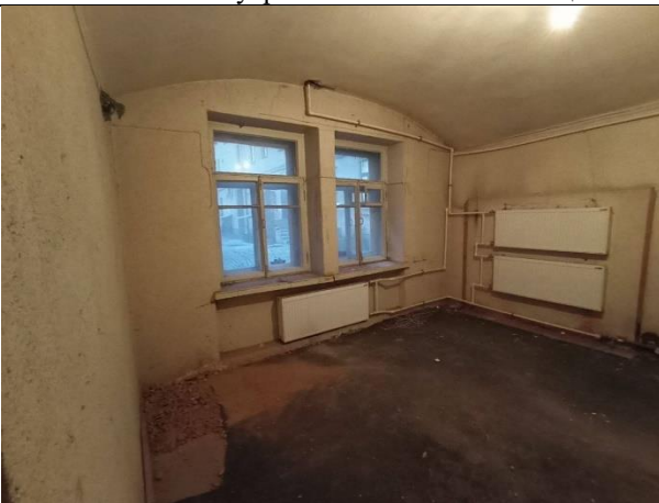
Фото № 17 – Внутреннее состояние помещения
