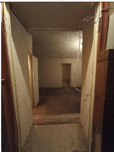
Фото № 9 – Внутреннее состояние помещения
