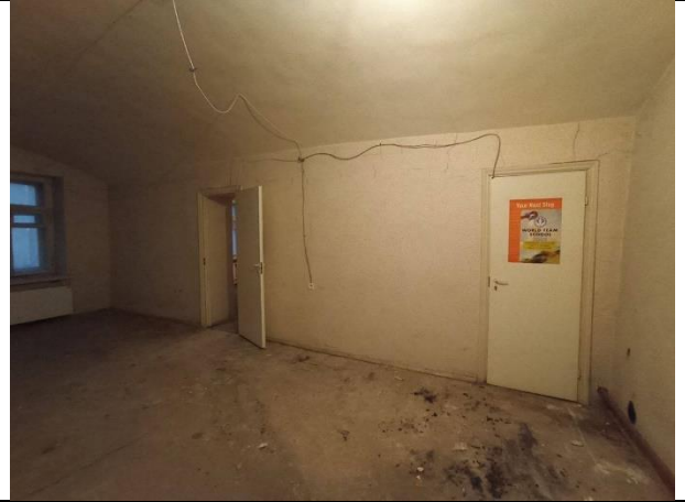
Фото № 14 – Внутреннее состояние помещения
