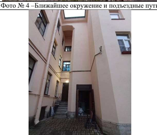
Фото № 6 – Вход в помещение
