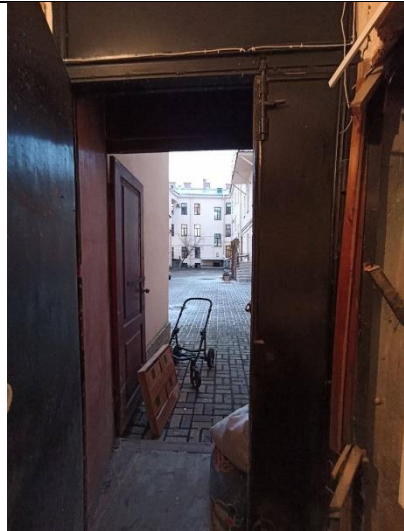
Фото № 22 – Внутреннее состояние помещения
