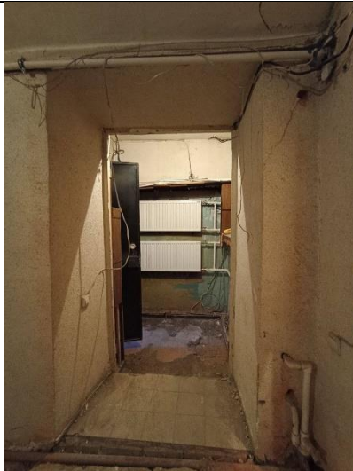
Фото № 21 – Внутреннее состояние помещения
