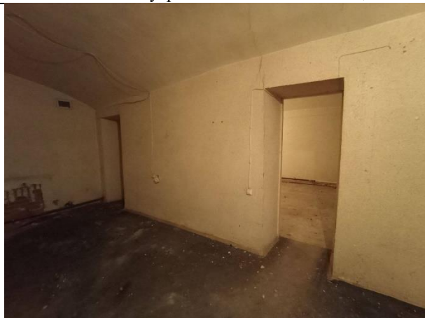
Фото № 11 – Внутреннее состояние помещения
