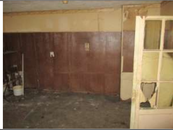
Фото 9. Внутреннее состояние Объекта оценки
