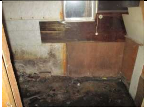
Фото 12. Внутреннее состояние Объекта оценки
