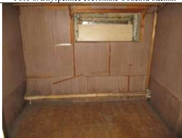
Фото 8. Внутреннее состояние Объекта оценки
