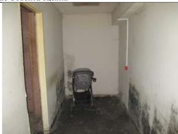
Фото 6. Внутреннее состояние Объекта оценки
