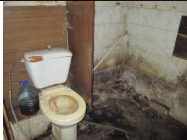
Фото 11. Внутреннее состояние Объекта оценки
