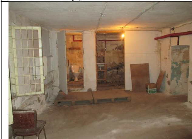
Фото № 9 – Внутреннее состояние помещения
