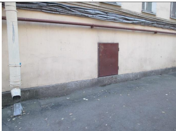
Фото № 5 – Переоборудованный оконный проем
