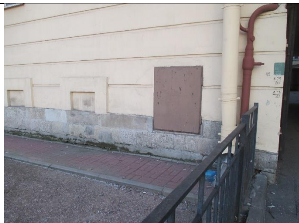
Фото № 6 – Переоборудованный оконный проем
