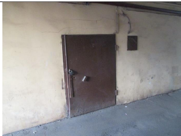
Фото № 4 – Вход в помещение из-под арки
