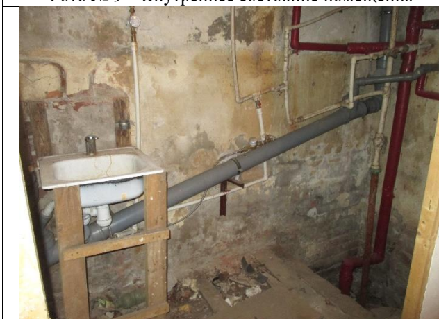
Фото № 11 – Внутреннее состояние помещения
