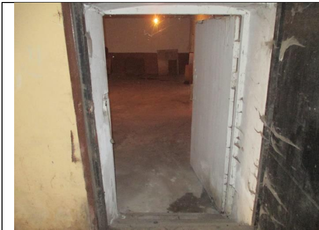
Фото № 7 – Внутреннее состояние помещения
