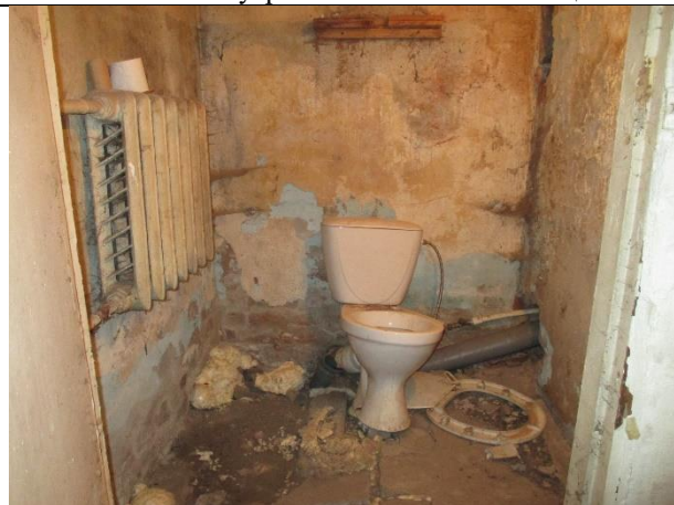
Фото № 10 – Внутреннее состояние помещения
