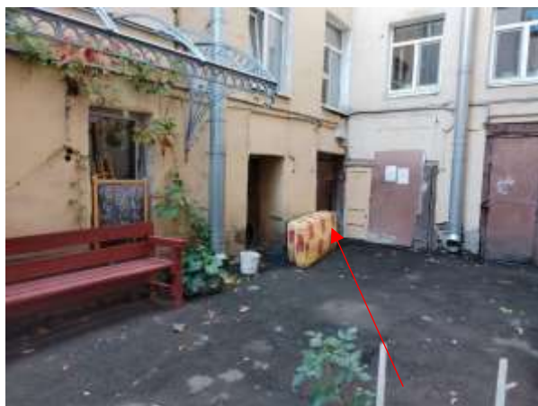
Фото 7. Отдельный вход со двора 10-Н
