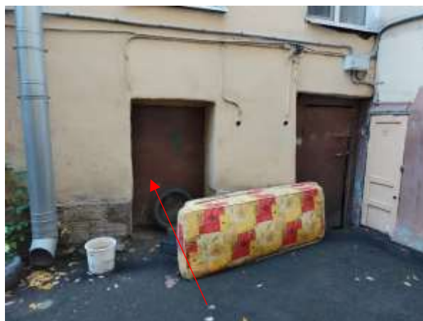
Фото 8. Отдельный вход со двора 11-Н
