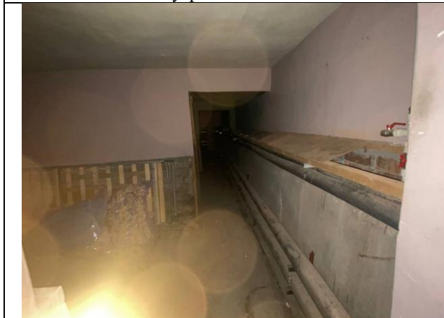
Фото № 13 – Внутреннее состояние помещения
