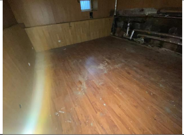
Фото № 18 – Внутреннее состояние помещения
