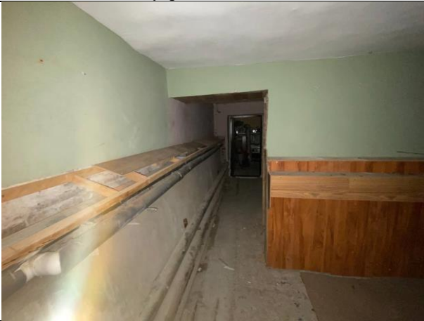
Фото № 19 – Внутреннее состояние помещения
