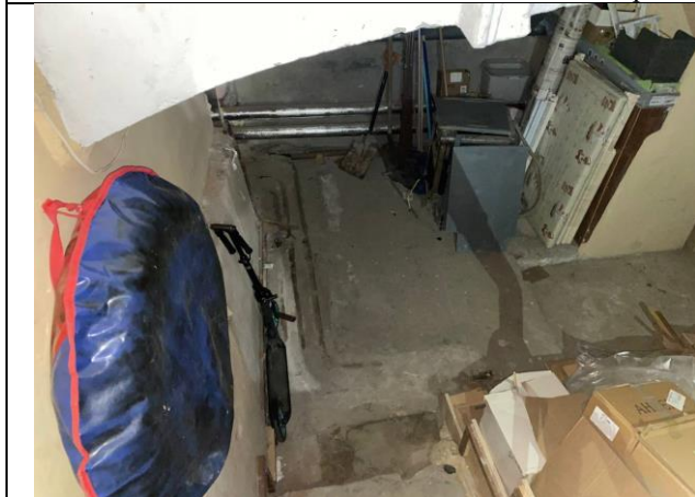
Фото № 9 – Внутреннее состояние помещения
