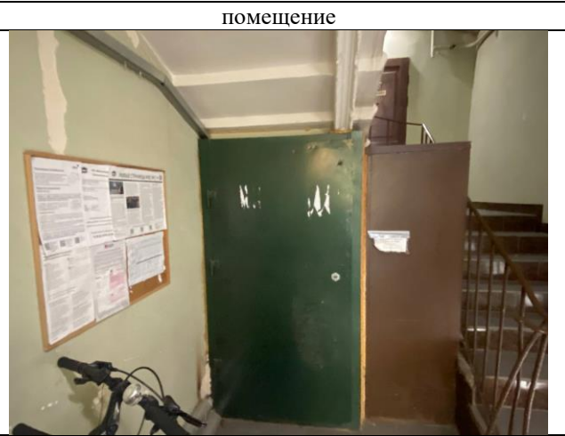
Фото № 8 – Вход в помещение с лестничной клетки
