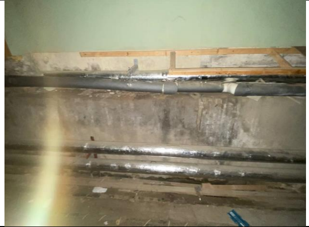
Фото № 16 Внутреннее состояние помещения
