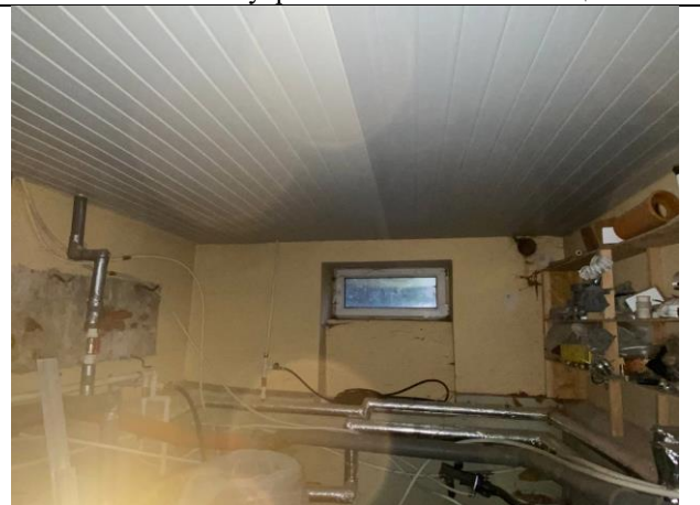
Фото № 12 – Внутреннее состояние помещения
