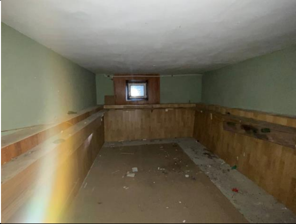
Фото № 15 – Внутреннее состояние помещения
