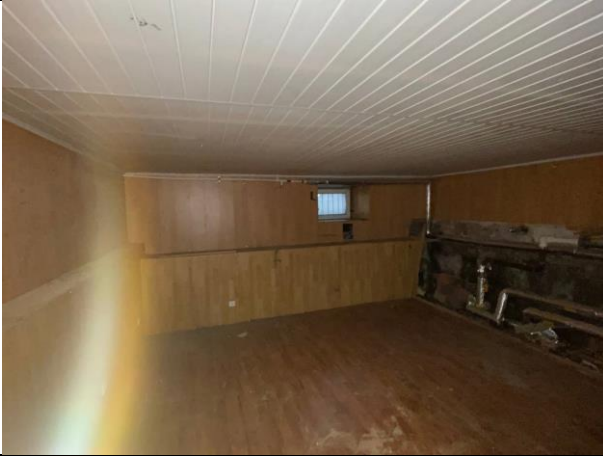
Фото № 17 – Внутреннее состояние помещения
