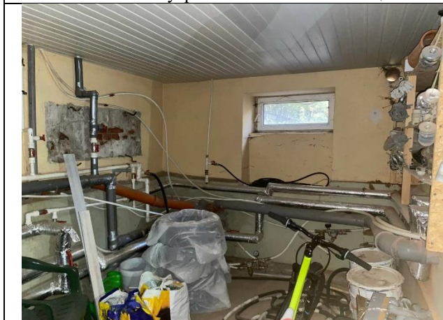
Фото № 11 – Внутреннее состояние помещения
