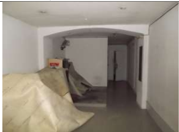
Фото 8. Внутреннее состояние Объекта оценки
