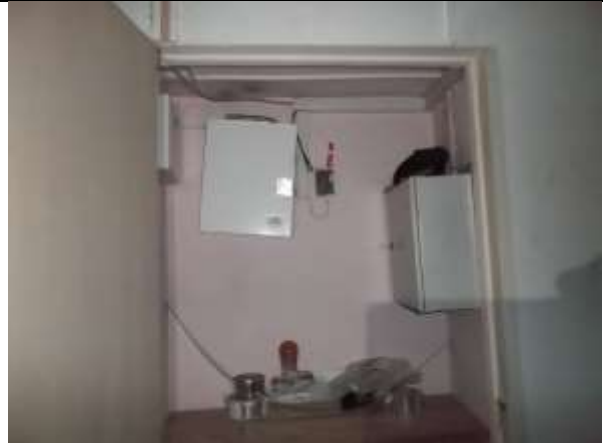
Фото 12. Внутреннее состояние Объекта оценки
