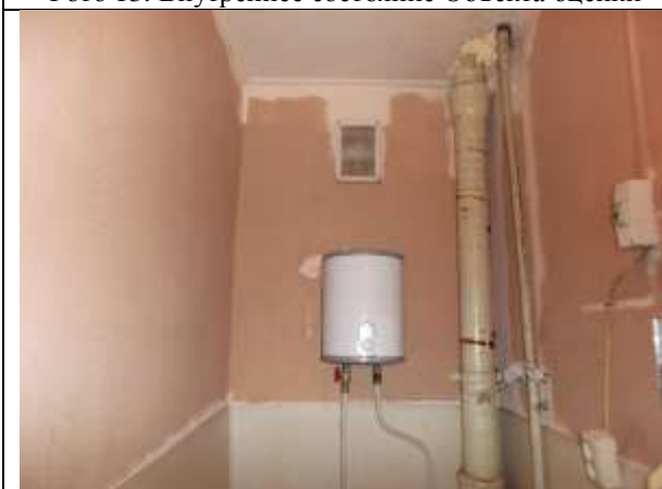
Фото 15. Внутреннее состояние Объекта оценки
