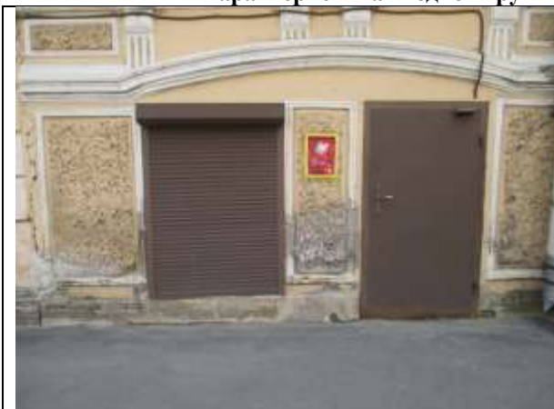
Фото 5. Отдельный вход с улицы и окно Объекта
