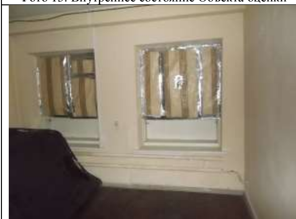
Фото 17. Внутреннее состояние Объекта оценки
