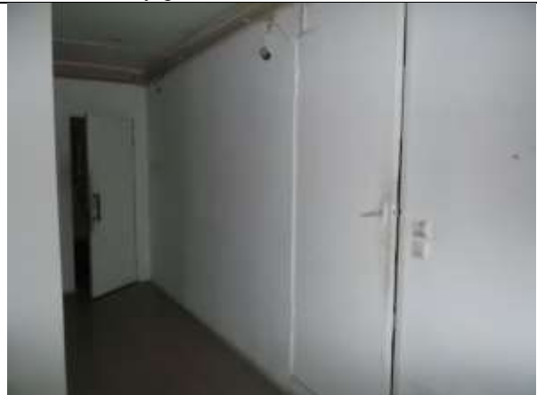
Фото 10. Внутреннее состояние Объекта оценки
