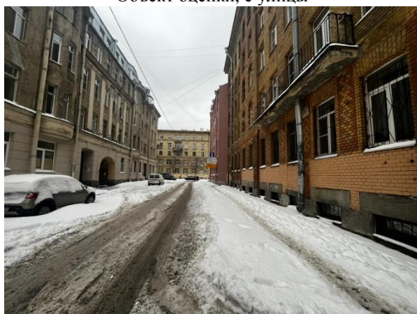
Фото 3. Вид здания, в котором расположен Объект оценки, со двора
