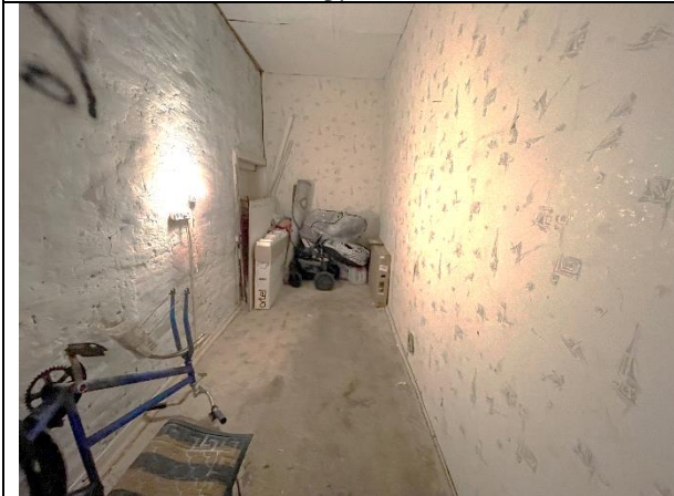
Фото 27. Типичное состояние Объекта оценки
