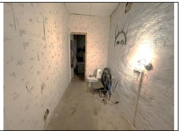
Фото 26. Типичное состояние Объекта оценки
