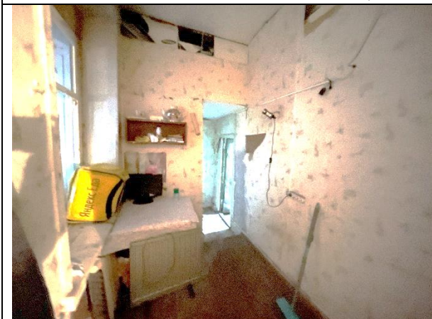
Фото 29. Типичное состояние Объекта оценки
