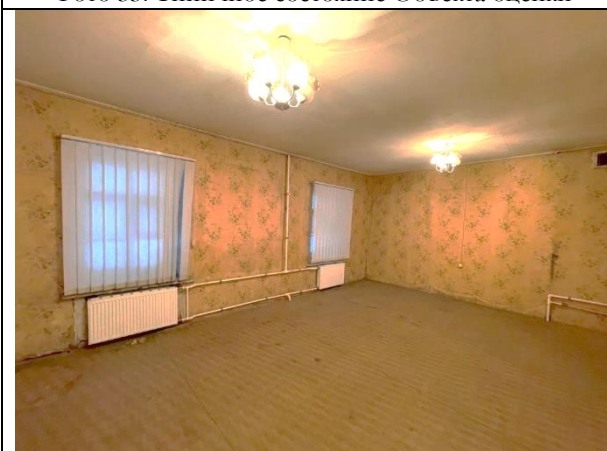
Фото 35. Типичное состояние Объекта оценки
