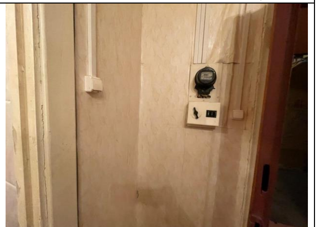
Фото 42. Типичное состояние Объекта оценки
