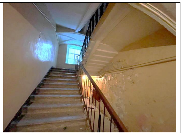
Фото 22. Лестничный проём объекта оценки
