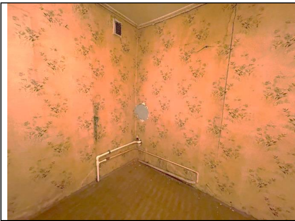
Фото 37. Типичное состояние Объекта оценки
