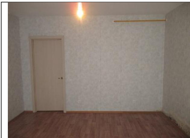
Фото № 11 – Внутреннее состояние помещения
