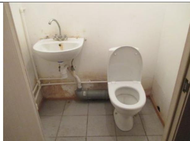
Фото № 12 – Внутреннее состояние помещения
