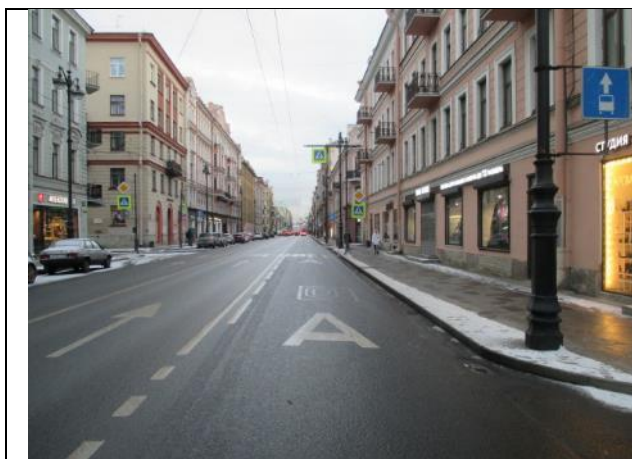
Фото № 1 – Подъездные пути
