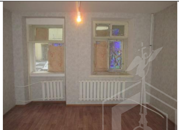
Фото № 10 – Внутреннее состояние помещения
