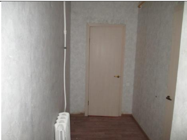
Фото № 9 – Внутреннее состояние помещения
