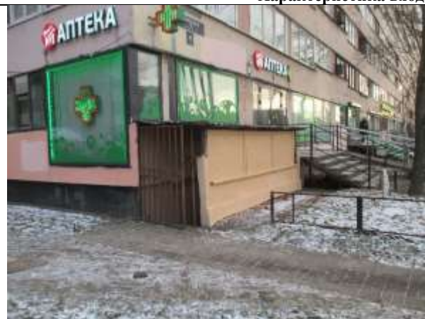
Фото 3. Отдельный вход с улицы
