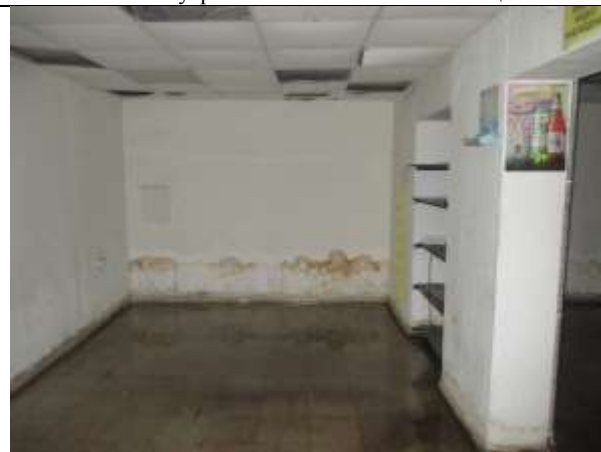
Фото 7. Внутреннее состояние Объекта оценки
