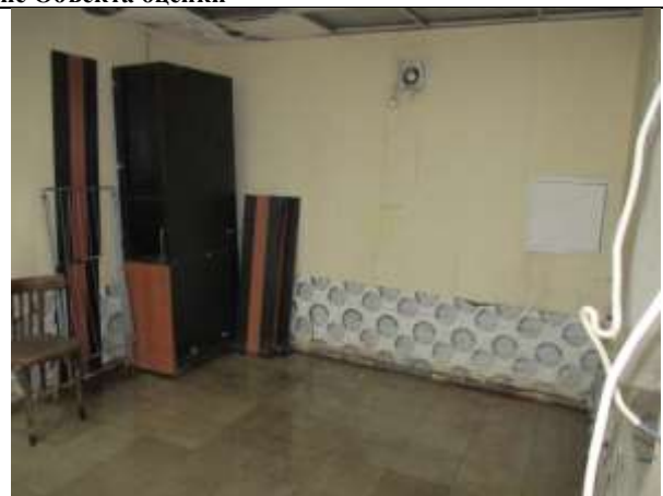
Фото 6. Внутреннее состояние Объекта оценки
