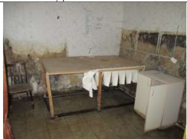
Фото 8. Внутреннее состояние Объекта оценки
