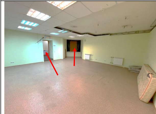
Фото 29. Типичное состояние Объекта оценки, оконная группа Объекта оценки
