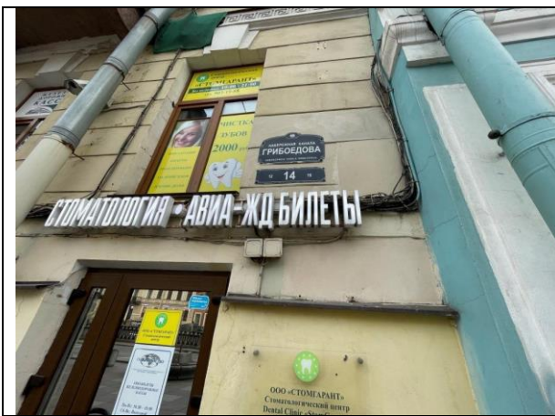
Фото 19. Адрес объекта оценки
