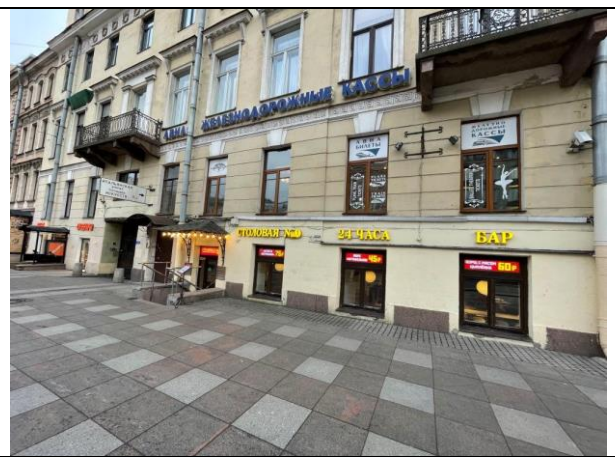
Фото 20. Вид здания Объекта оценки
