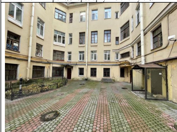
Фото 23. Внутривдворовая территория Объекта оценки
