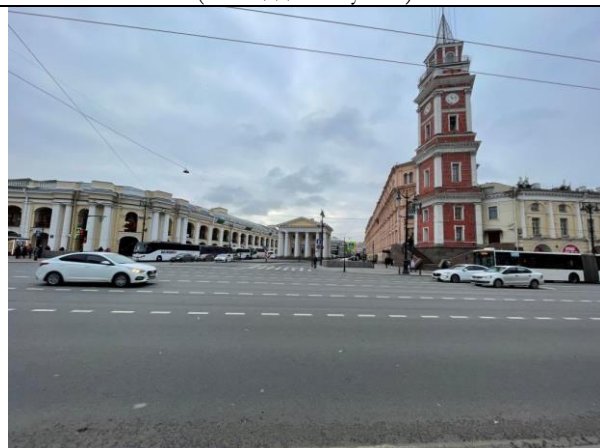
Фото 7. Ближайшее окружение Объекта оценки (Невский проспект)
