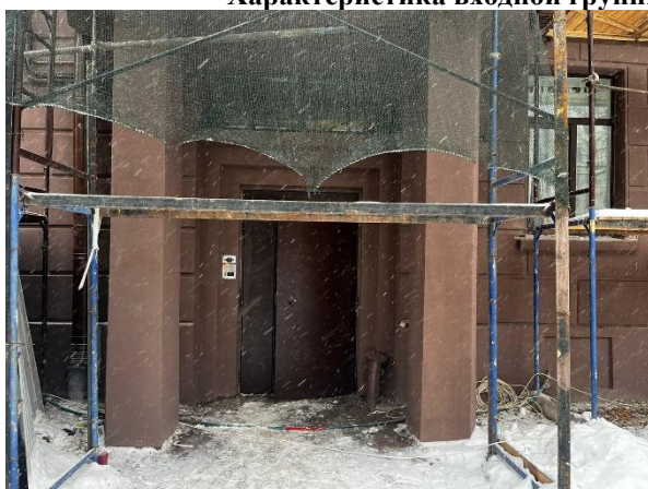
Фото 4. Общий вход со двора
