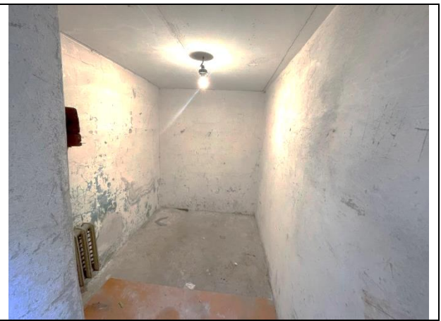
Фото 24. Типичное состояние Объекта оценки
