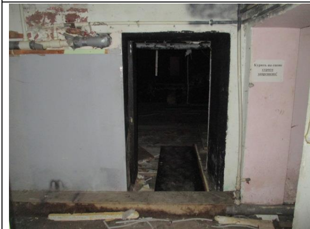
Фото № 13 – Внутреннее состояние помещения
