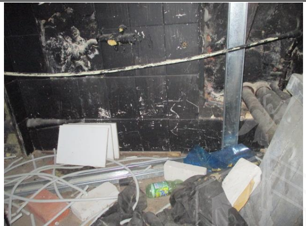
Фото № 22 – Внутреннее состояние помещения
