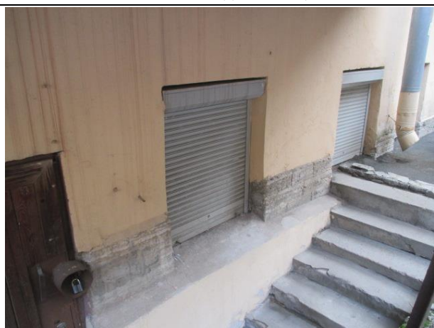
Фото № 10 – Расположение окон помещения
