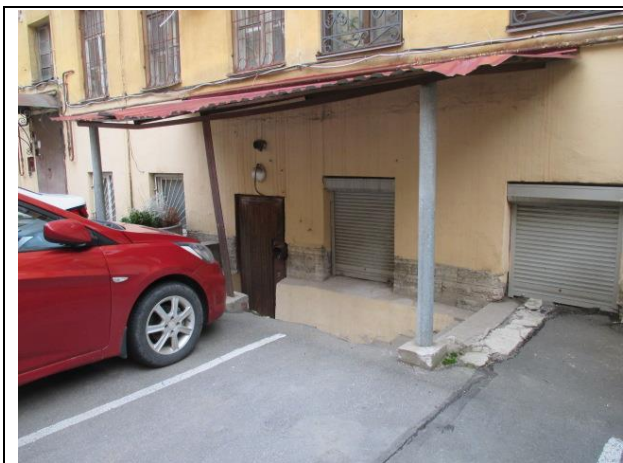
Фото № 7 – Вход в помещение
