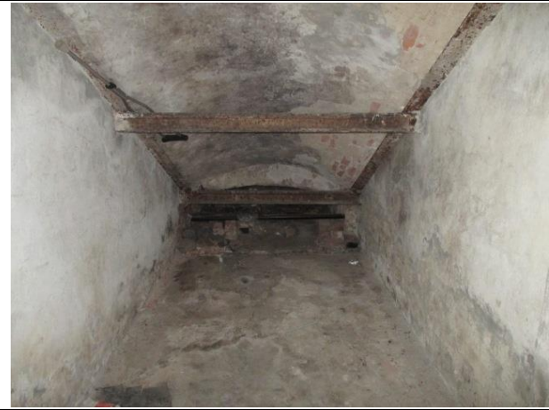
Фото № 15 – Внутреннее состояние помещения
