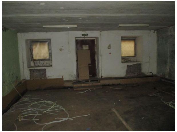
Фото № 16 – Внутреннее состояние помещения
