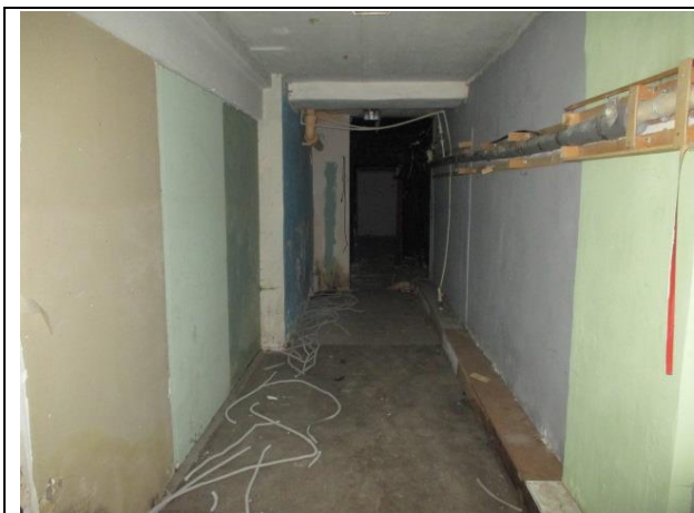
Фото № 23 – Внутреннее состояние помещения
