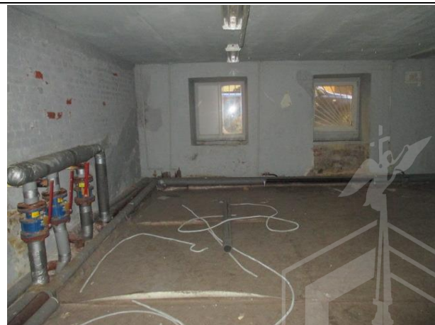
Фото № 30 – Внутреннее состояние помещения
