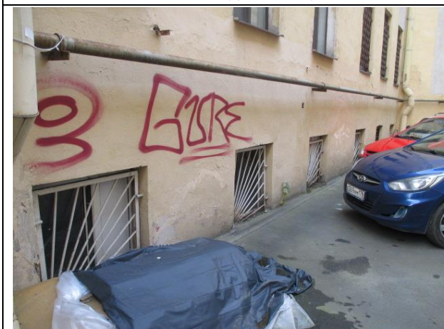
Фото № 9 – Расположение окон помещения
