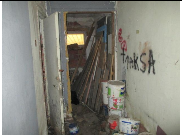
Фото № 20 – Внутреннее состояние помещения
