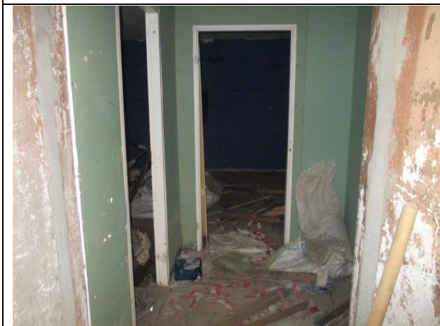
Фото № 11 – Внутреннее состояние помещения
