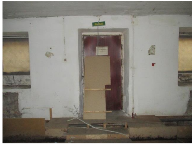
Фото № 18 – Внутреннее состояние помещения
