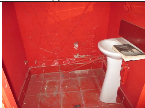
Фото № 25 – Внутреннее состояние помещения
