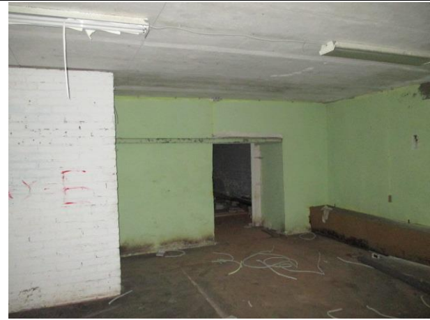
Фото № 17 – Внутреннее состояние помещения
