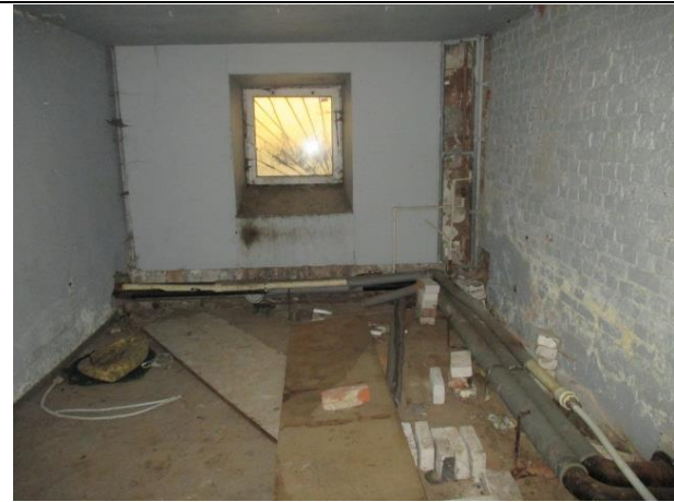
Фото № 19 – Внутреннее состояние помещения
