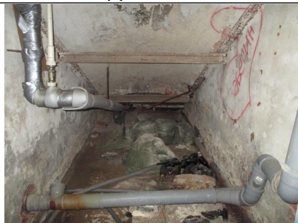
Фото № 27 – Внутреннее состояние помещения
