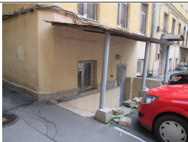
Фото № 8 – Вход в помещение
