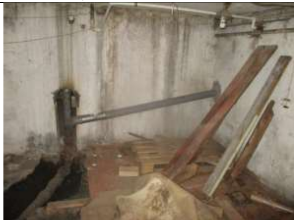
Фото 6. Внутреннее состояние Объекта оценки
