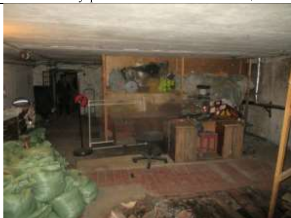
Фото 10. Внутреннее состояние Объекта оценки
