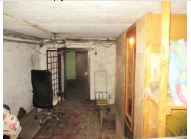
Фото 14. Внутреннее состояние Объекта оценки
