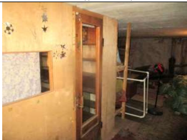
Фото 7. Внутреннее состояние Объекта оценки
