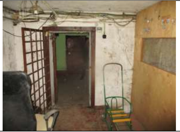
Фото 12. Внутреннее состояние Объекта оценки
