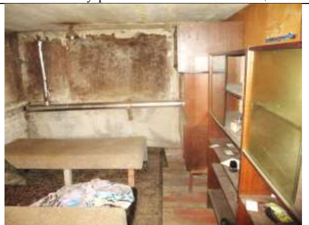
Фото 16. Внутреннее состояние Объекта оценки
