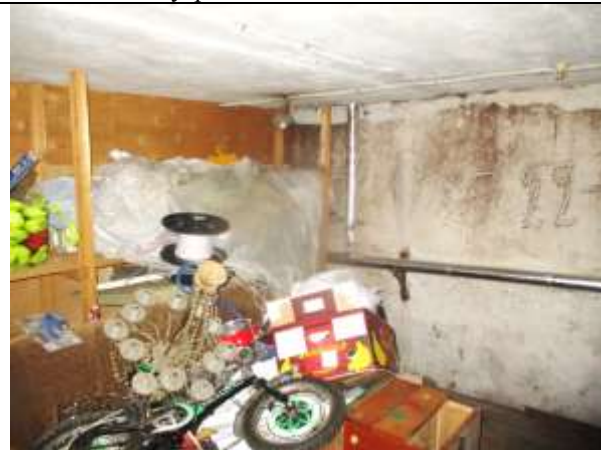
Фото 13. Внутреннее состояние Объекта оценки
