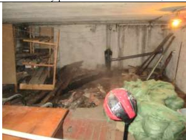
Фото 8. Внутреннее состояние Объекта оценки
