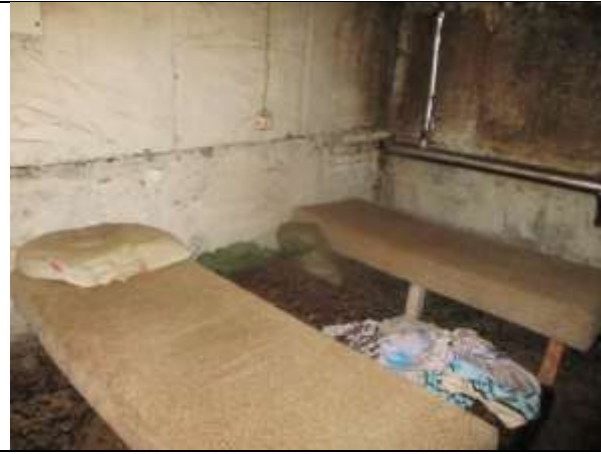
Фото 11. Внутреннее состояние Объекта оценки
