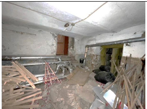
Фото 32. Типичное состояние Объекта оценки
