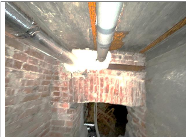
Фото 39. Типичное состояние Объекта оценки
