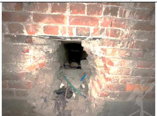
Фото 38. Типичное состояние Объекта оценки
