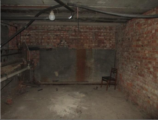
Фото № 15 – Внутреннее состояние помещения
