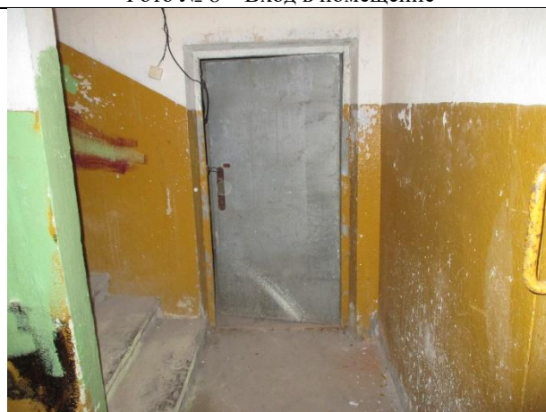
Фото № 10 – Внутреннее состояние помещения
