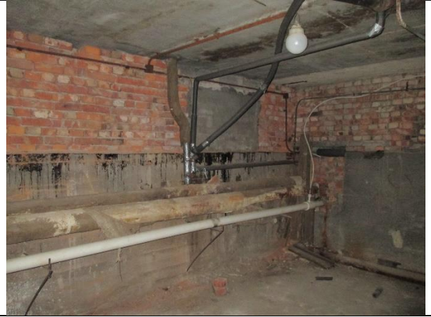
Фото № 16 – Внутреннее состояние помещения
