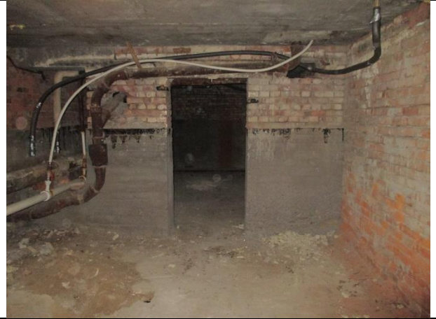
Фото № 14 – Внутреннее состояние помещения
