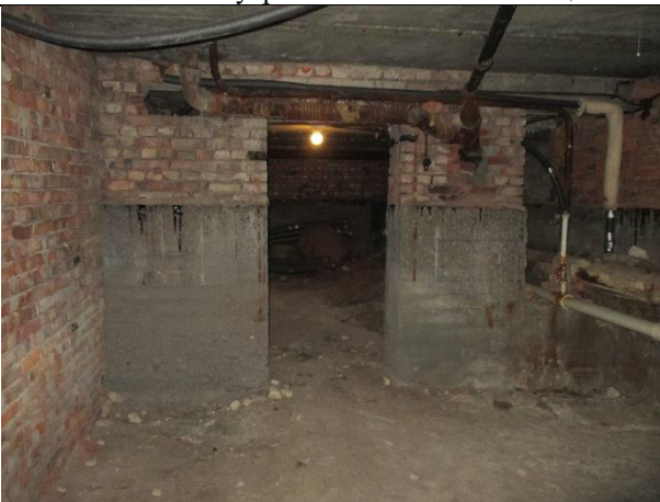
Фото № 17 – Внутреннее состояние помещения
