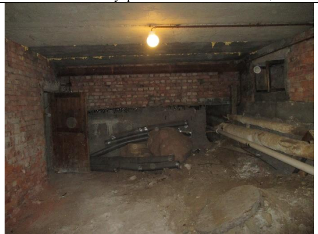
Фото № 18 – Внутреннее состояние помещения
