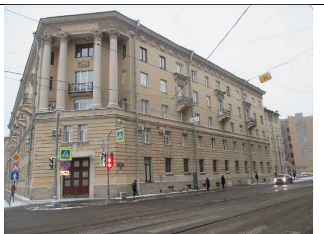
Фото № 2 – Подъездные пути
