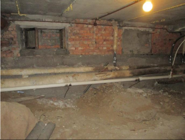
Фото № 13 – Внутреннее состояние помещения
