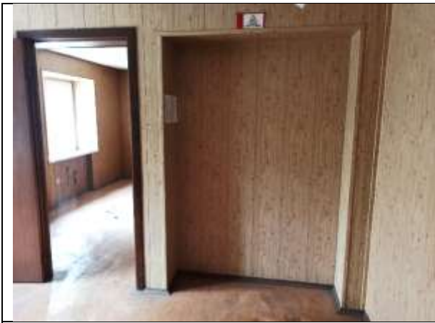
Фото 15. Внутреннее состояние Объекта оценки
