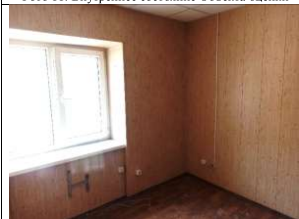
Фото 13. Внутреннее состояние Объекта оценки
