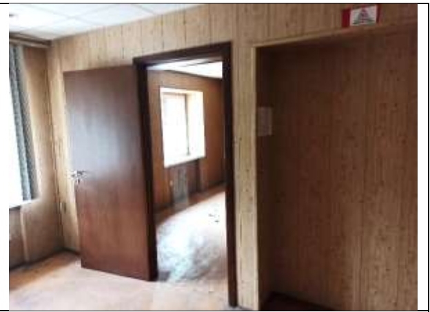
Фото 16. Внутреннее состояние Объекта оценки
