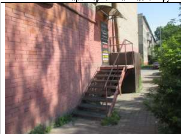
Фото 5. Общий с нежилым помещением вход со двора (с торца здания)
