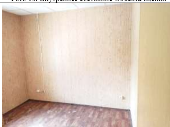
Фото 12. Внутреннее состояние Объекта оценки
