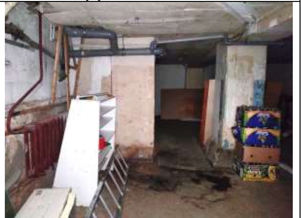
Фото 18. Внутреннее состояние Объекта оценки
