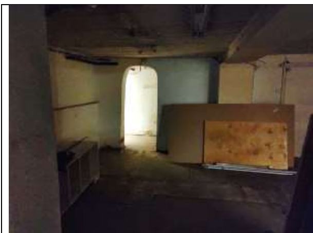
Фото 23. Внутреннее состояние Объекта оценки
