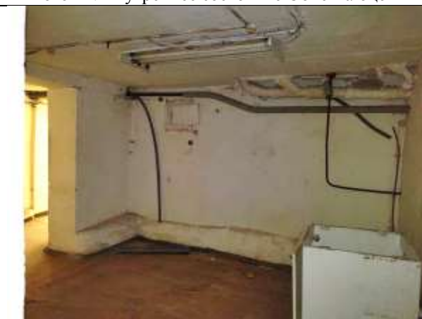
Фото 14. Внутреннее состояние Объекта оценки
