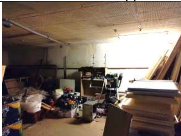
Фото 9. Внутреннее состояние Объекта оценки
