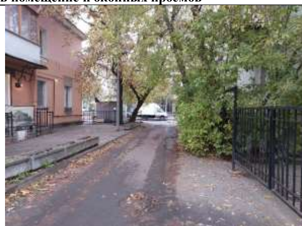
Фото 6. Отдельный вход Объекта оценки со двора
