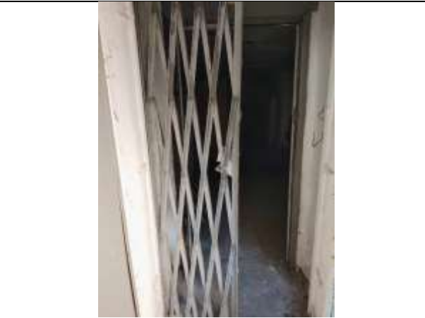
Фото 19. Внутреннее состояние Объекта оценки
