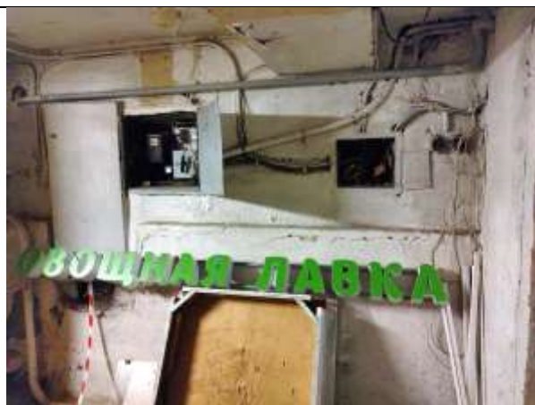
Фото 11. Внутреннее состояние Объекта оценки
