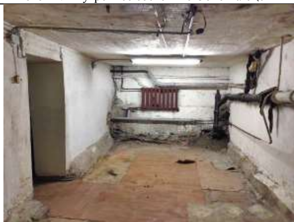
Фото 13. Внутреннее состояние Объекта оценки
