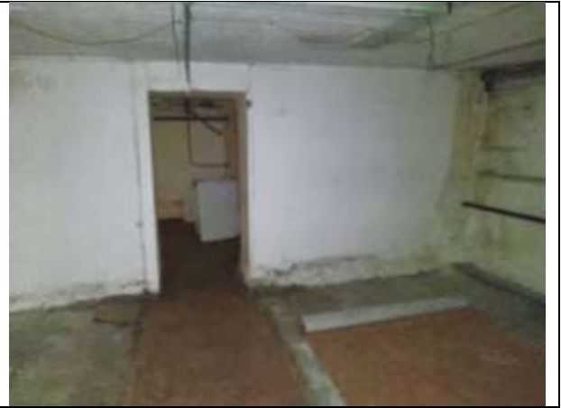
Фото 16. Внутреннее состояние Объекта оценки
