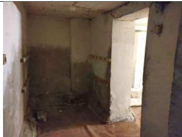
Фото 10. Внутреннее состояние Объекта оценки (доступ из соседнего помещения)
