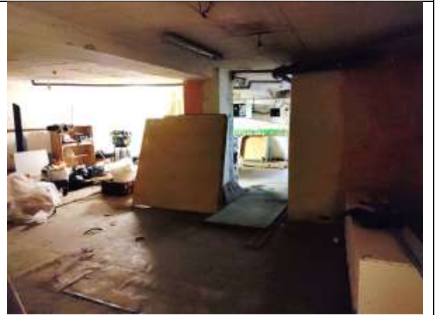
Фото 20. Внутреннее состояние Объекта оценки
