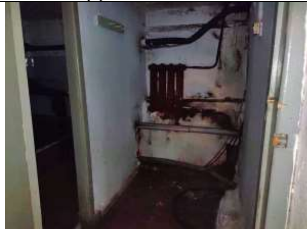
Фото 17. Внутреннее состояние Объекта оценки
