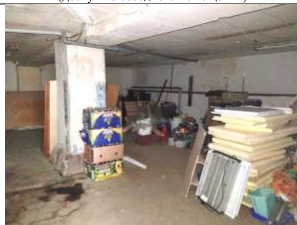
Фото 12. Внутреннее состояние Объекта оценки
