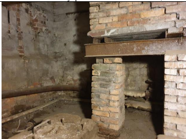
Фото № 21 – Внутреннее состояние помещения
