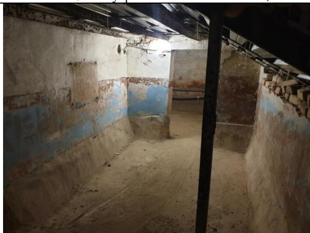
Фото № 25 – Внутреннее состояние помещения
