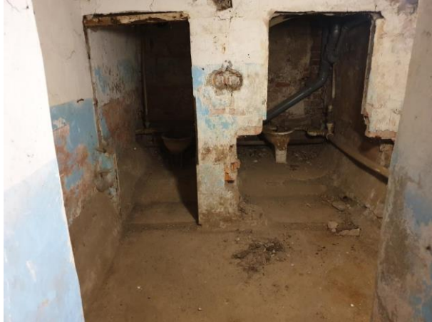
Фото № 17 – Внутреннее состояние помещения
