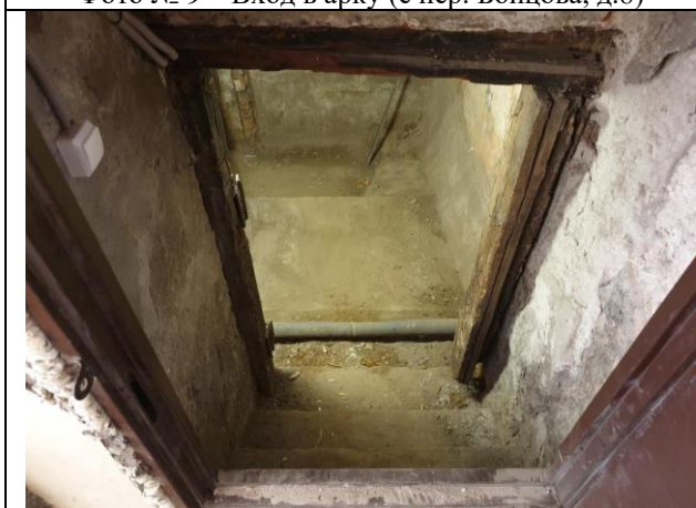
Фото № 11 – Вход в помещение из-под арки
