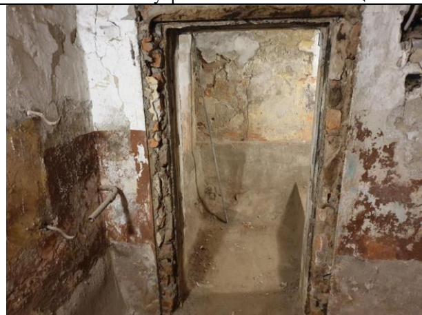
Фото № 26 – Внутреннее состояние помещения
