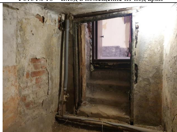
Фото № 12 – Внутреннее состояние помещения
