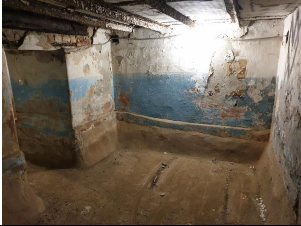
Фото № 15 – Внутреннее состояние помещения
