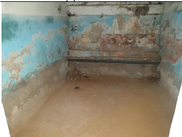
Фото № 19 – Внутреннее состояние помещения
