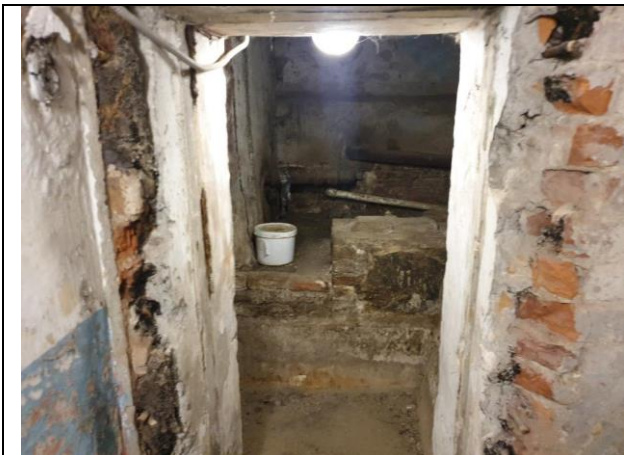
Фото № 23 – Внутреннее состояние помещения
