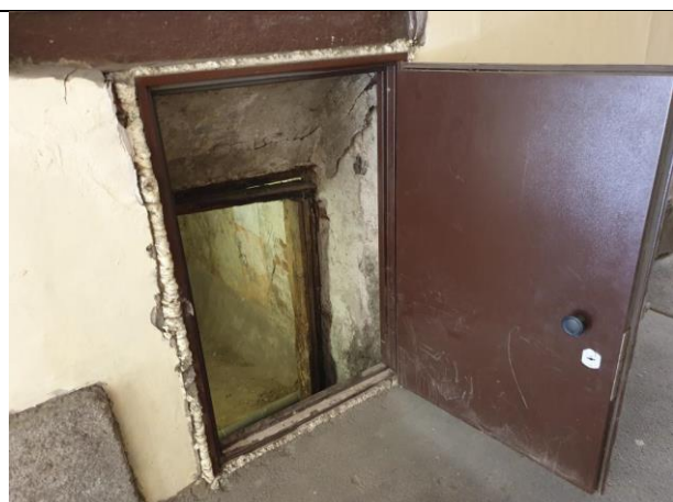
Фото № 10 – Вход в помещение из-под арки
