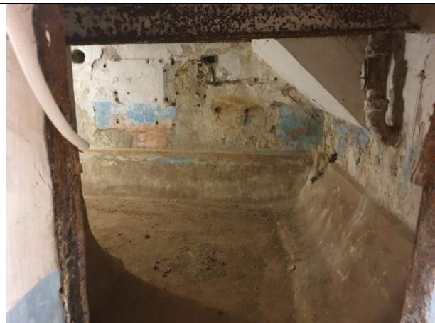
Фото № 24 – Внутреннее состояние помещения
