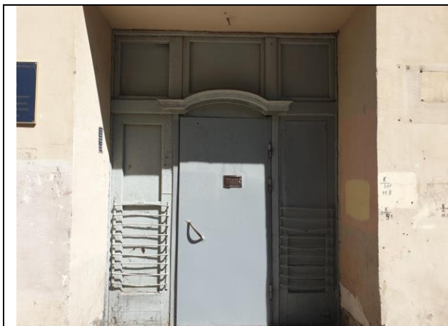
Фото № 7 – Вход в подъезд, где расположен вход в помещение (с пер. Бойцова, д.8)
