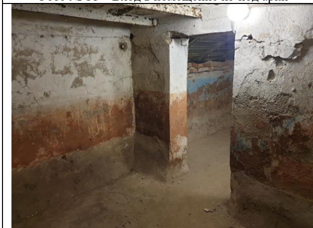
Фото № 13 – Внутреннее состояние помещения
