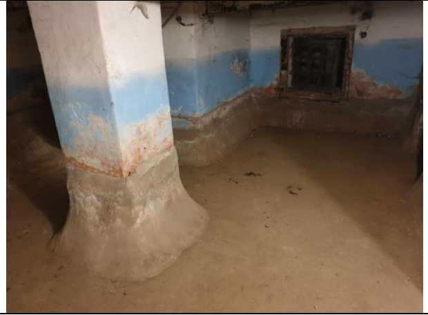
Фото № 16 – Внутреннее состояние помещения
