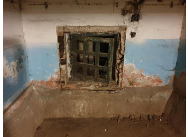
Фото № 18 – Внутреннее состояние помещения
