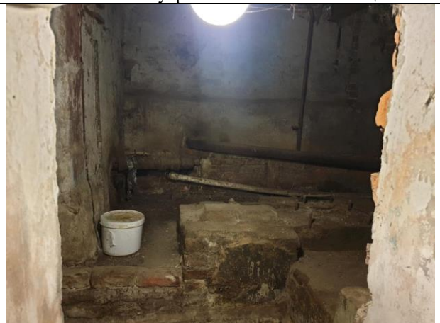
Фото № 20 – Внутреннее состояние помещения
