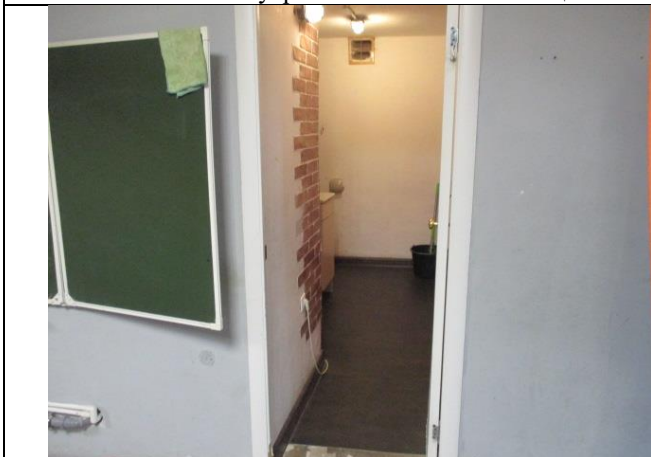
Фото № 15– Внутреннее состояние помещений
