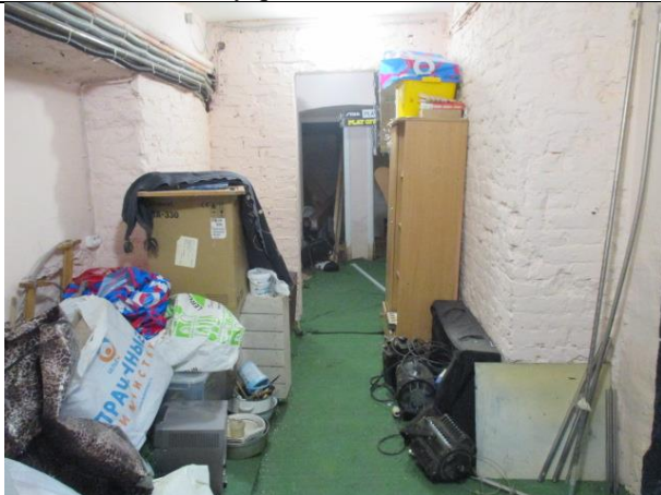
Фото № 23– Внутреннее состояние помещений
