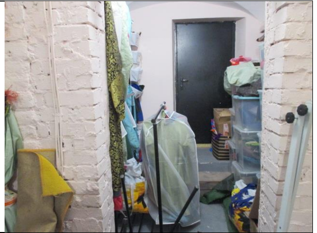
Фото № 22– Внутреннее состояние помещений
