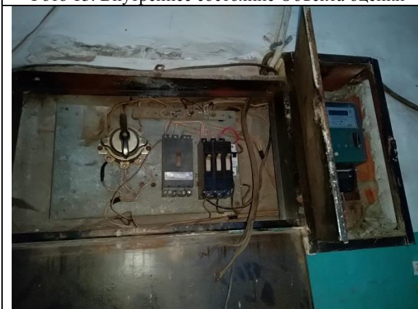
Фото 15. Внутреннее состояние Объекта оценки
