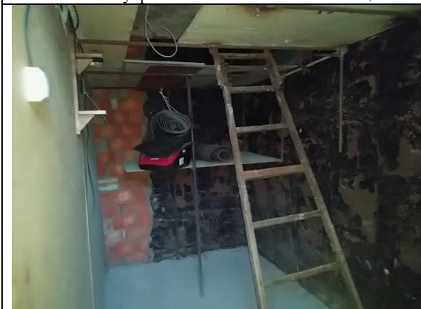
Фото 19. Внутреннее состояние Объекта оценки
