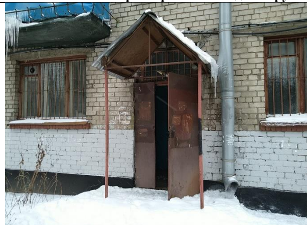
Фото 5 Отдельный вход со двора и окна
