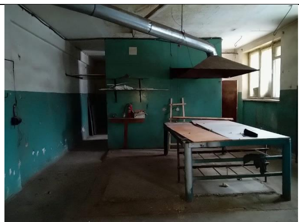
Фото 14. Внутреннее состояние Объекта оценки
