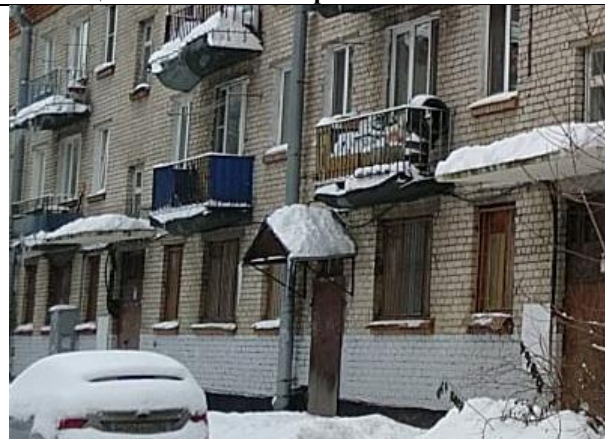
Фото 6. Отдельный вход со двора и окна
