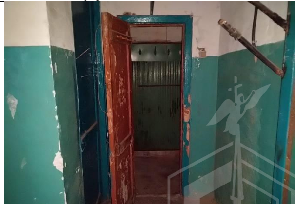
Фото 12. Внутреннее состояние Объекта оценки
