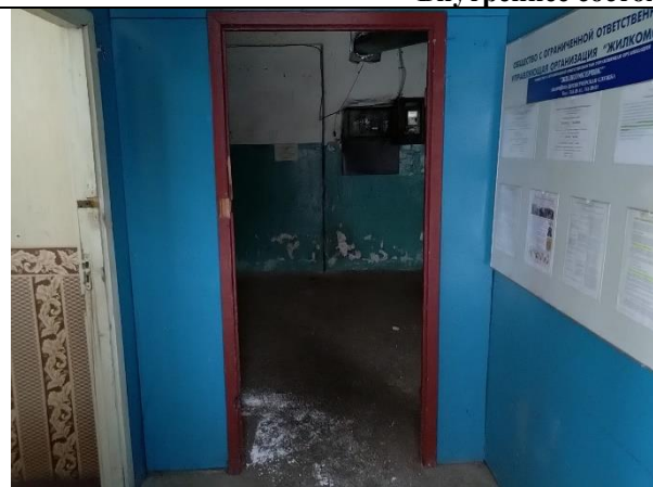
Фото 7. Внутреннее состояние Объекта оценки
