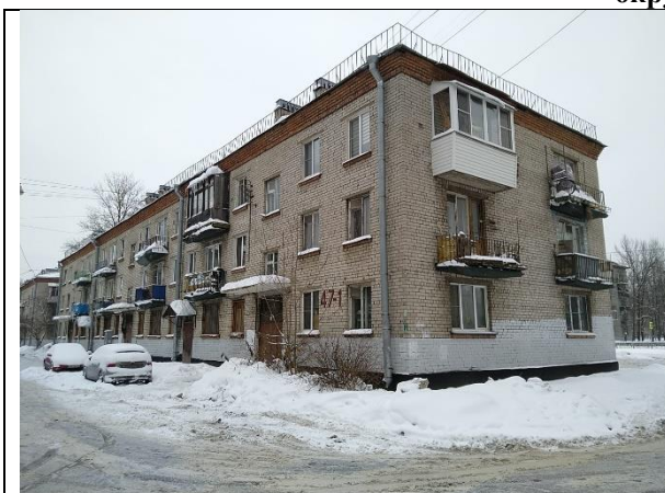
Фото 1. Вид здания, в котором расположен Объект оценки
