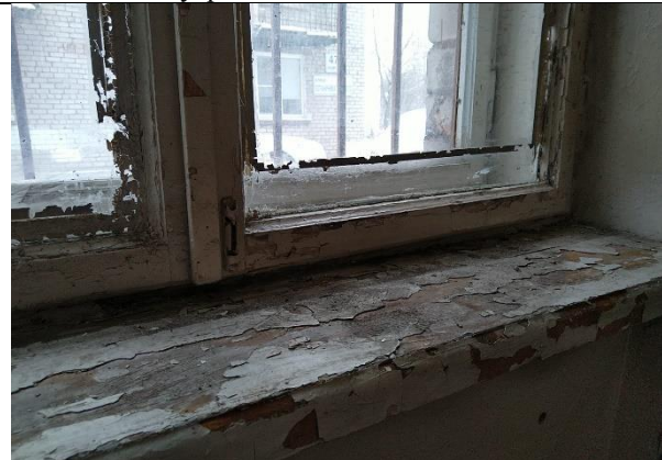
Фото 11. Внутреннее состояние Объекта оценки
