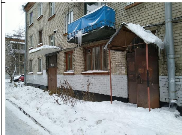
Фото 3. Вид здания, в котором расположен Объект оценки
