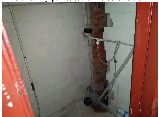
Фото 18. Внутреннее состояние Объекта оценки
