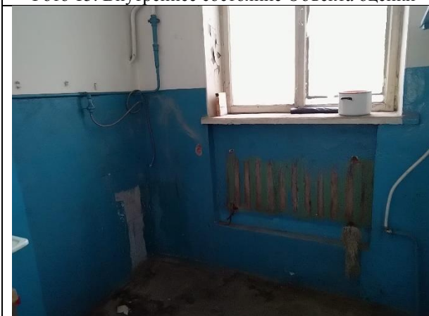
Фото 17. Внутреннее состояние Объекта оценки
