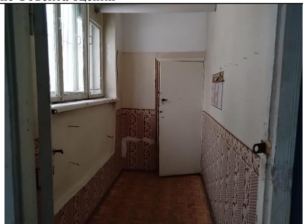
Фото 8. Внутреннее состояние Объекта оценки
