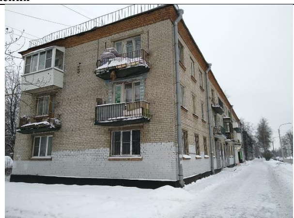
Фото 2. Вид здания, в котором расположен Объект оценки
