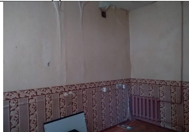
Фото 9. Внутреннее состояние Объекта оценки
