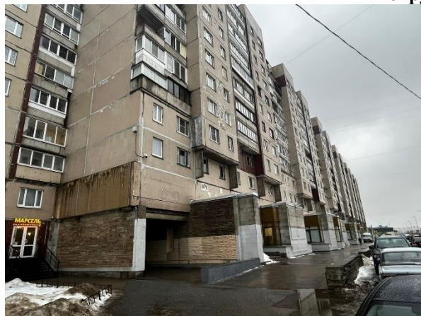
Фото 1. Вид здания, в котором расположен Объект оценки
