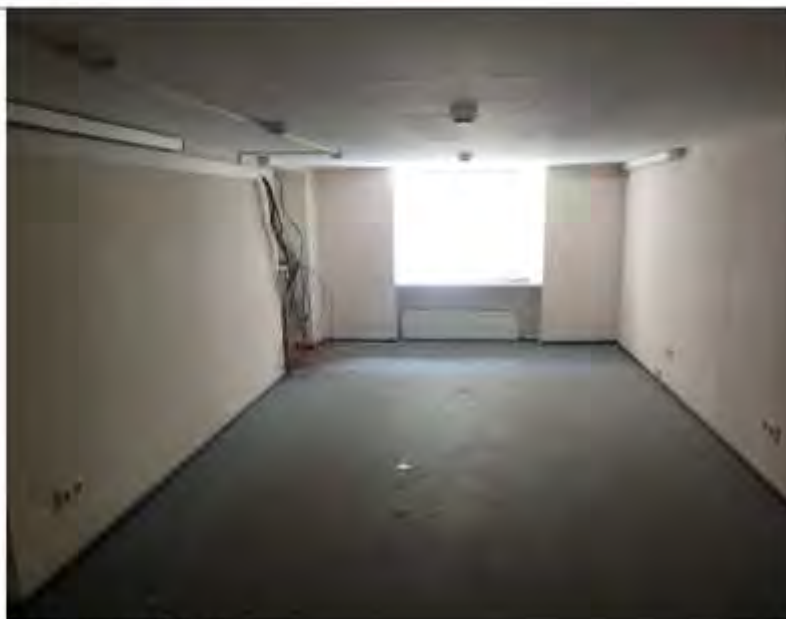
Описание: Вид внутри Объекта
