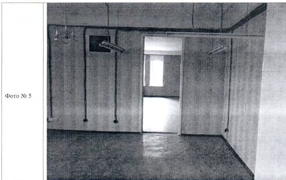
Описание: оборудован проем в стене между ч.п. 2 и ч.п. 3.
