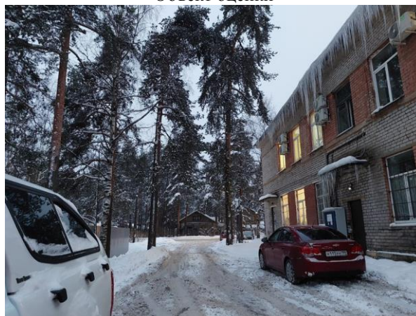
Фото 4. Ближайшее окружение. Доступ в помещение и оконных проемов
