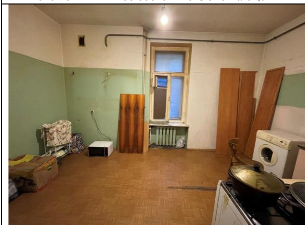
Фото 27. Типичное состояние Объекта оценки
