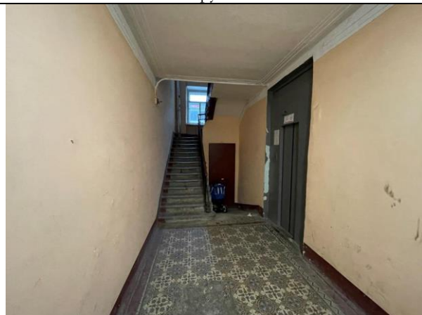
Фото 19. Лестничный проём Объекта оценки
