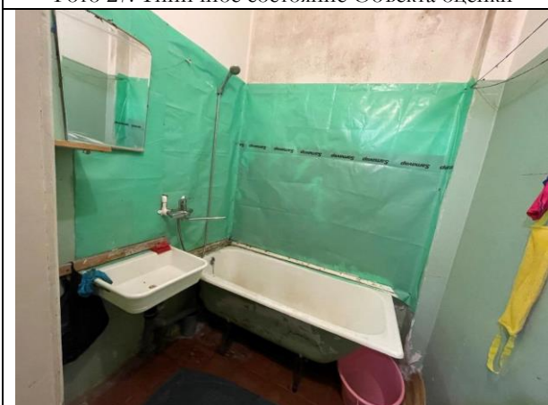
Фото 29. Типичное состояние Объекта оценки
