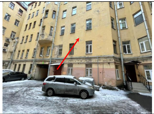
Фото 16. Вид здания расположения Объекта оценки
