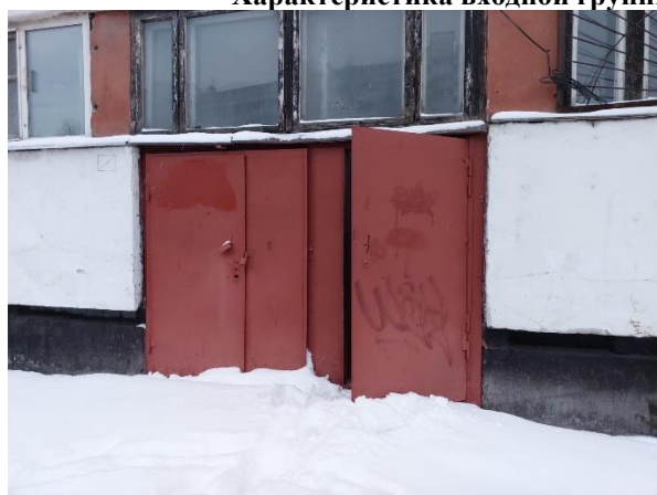
Фото 5. Отдельный вход с улицы
