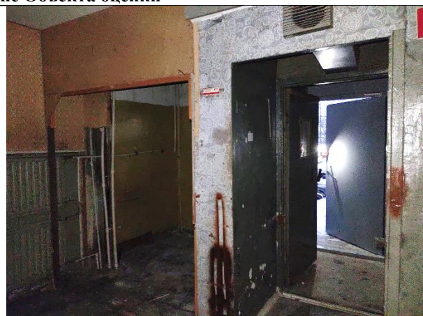
Фото 7. Внутреннее состояние Объекта оценки
