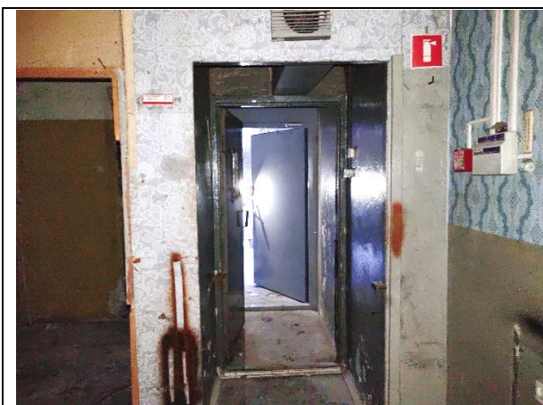
Фото 8. Внутреннее состояние Объекта оценки
