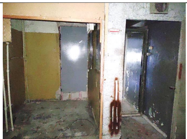
Фото 9. Внутреннее состояние Объекта оценки
