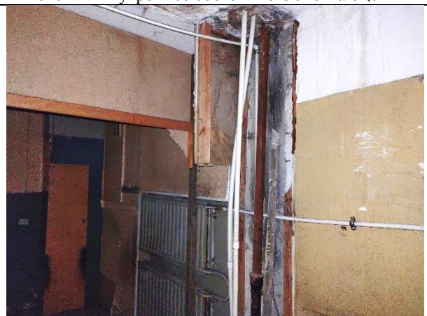
Фото 13. Внутреннее состояние Объекта оценки
