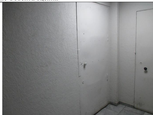
Фото 6. Внутреннее состояние Объекта оценки
