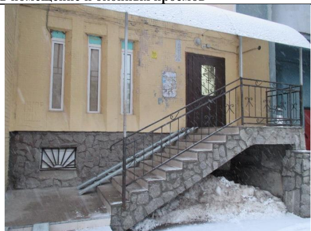
Фото 4. Отдельный вход и окна Объекта оценки
