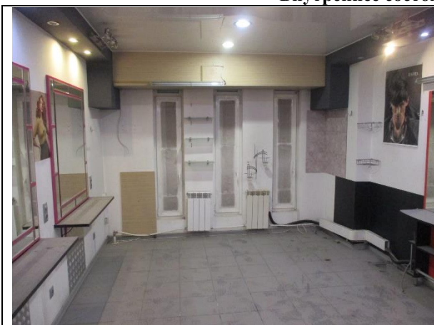
Фото 5. Внутреннее состояние Объекта оценки
