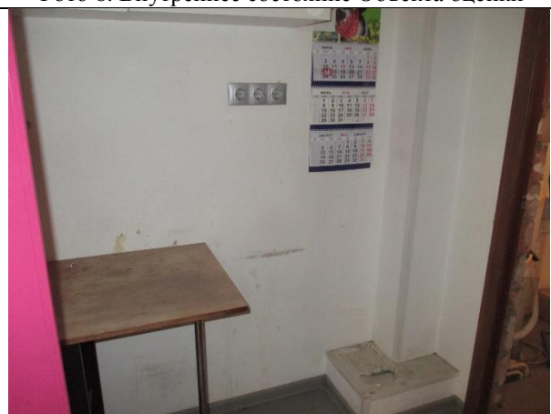
Фото 8. Внутреннее состояние Объекта оценки
