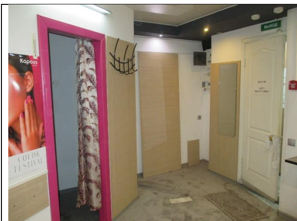
Фото 9. Внутреннее состояние Объекта оценки
