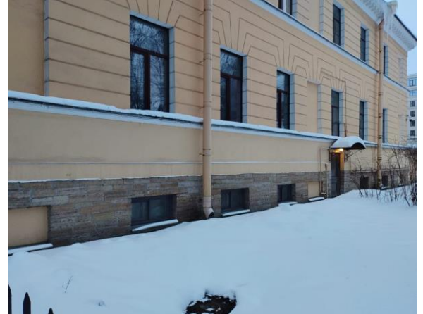
Фото 6. Общий вход с улицы Объекта оценки
