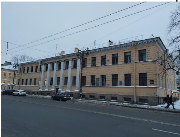
Фото 1. Вид здания Объекта оценки
