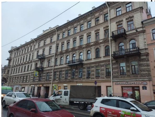
Фото 1. Вид здания Объекта оценки
