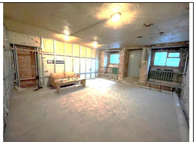
Фото 18. Типичное состояние Объекта оценки
