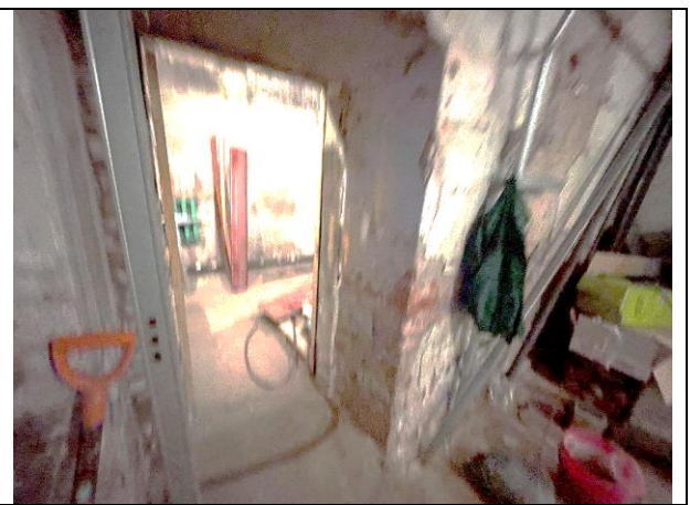
Фото 26. Типичное состояние Объекта оценки
