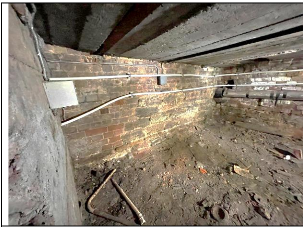
Фото 41. Типичное состояние Объекта оценки
