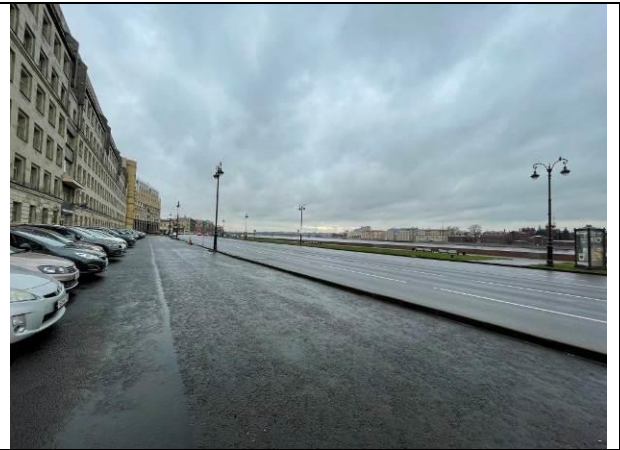
Фото 2. Ближайшее окружение объекта оценки (Воскресенская набережная)
