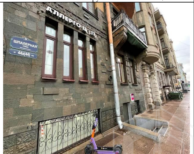
Фото 8. Вид здания расположения Объекта оценки с улицы, адрес Объекта оценки
