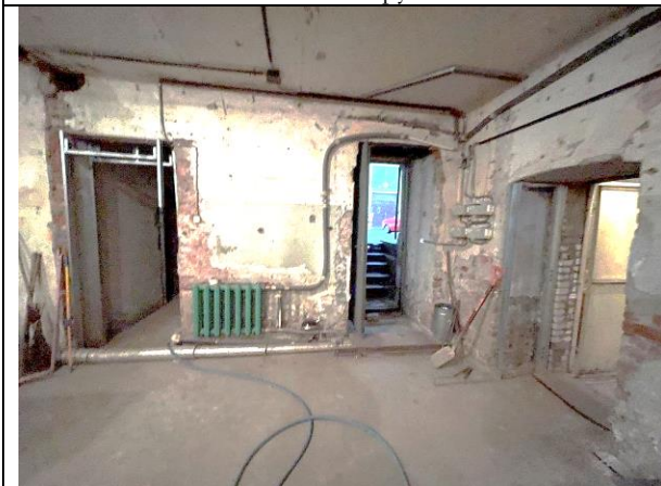
Фото 19. Типичное состояние Объекта оценки
