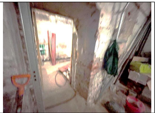
Фото 26. Типичное состояние Объекта оценки
