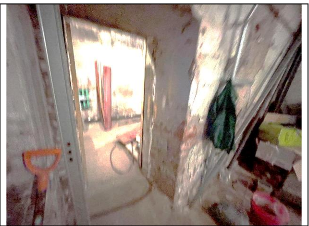
Фото 26. Типичное состояние Объекта оценки
