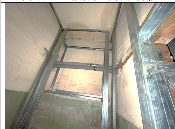
Фото 29. Типичное состояние Объекта оценки
