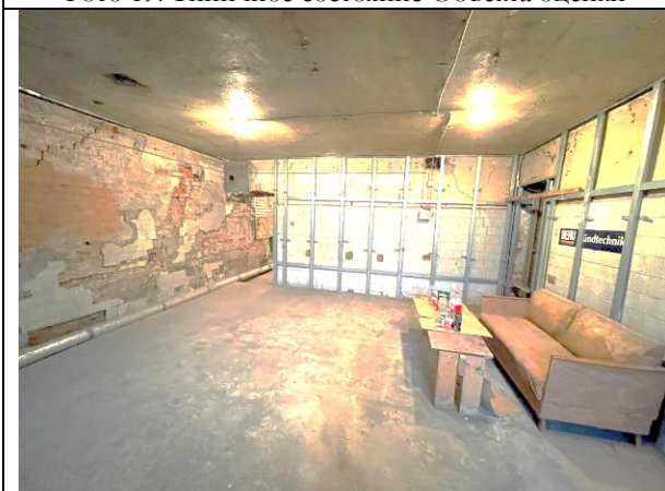
Фото 21. Типичное состояние Объекта оценки
