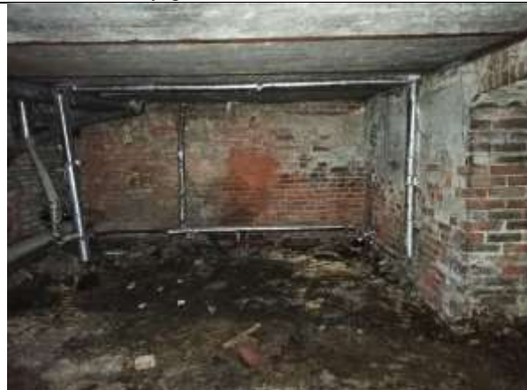
Фото 16. Внутреннее состояние Объекта оценки
