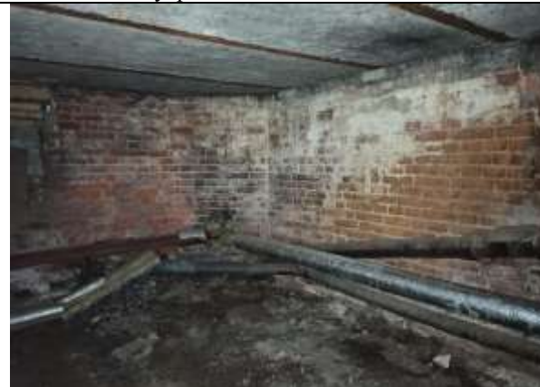
Фото 17. Внутреннее состояние Объекта оценки
