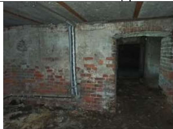
Фото 13. Внутреннее состояние Объекта оценки
