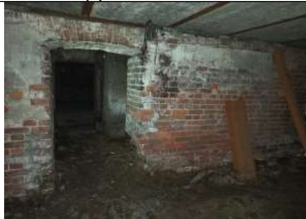
Фото 18. Внутреннее состояние Объекта оценки
