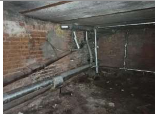
Фото 15. Внутреннее состояние Объекта оценки
