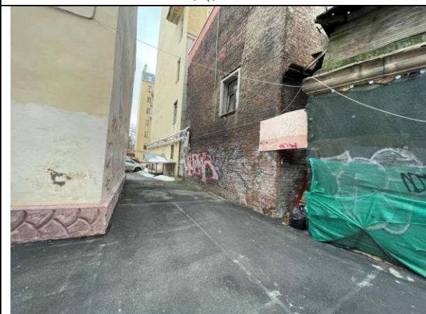
Фото 13. Вид здания расположения Объекта оценки
