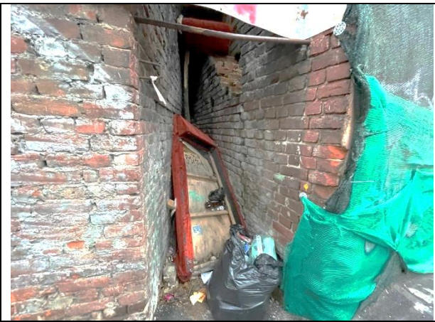
Фото 15. Вид здания расположения Объекта оценки
