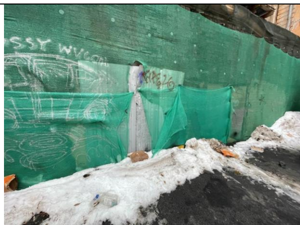
Фото 14. Вид здания расположения Объекта оценки
