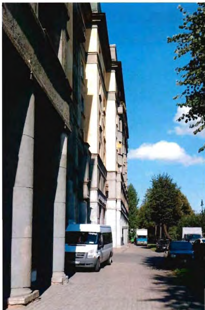
6. Фрагмент. Восточный фасад южного флигеля.
