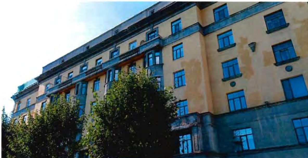
5. Фрагмент. Восточный фасад южного флигеля.
