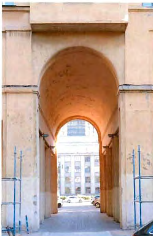
9. Фрагмент. Северная проездная арка северного флигеля.
