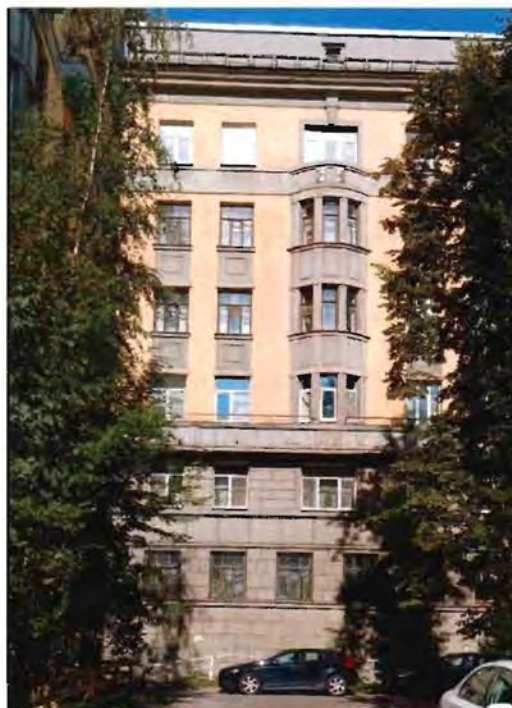
4. Фрагмент. Восточный фасад главного флигеля.
