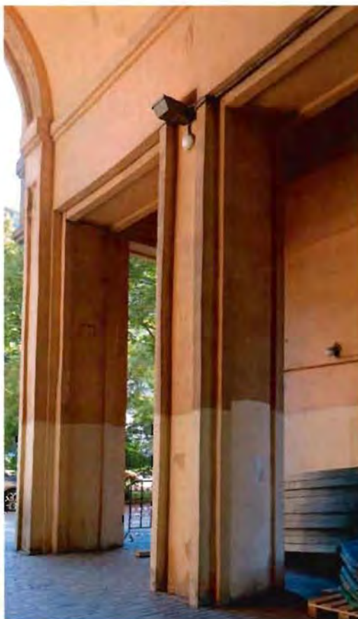
10. Фрагмент. Северная проездная арка северного флигеля.
