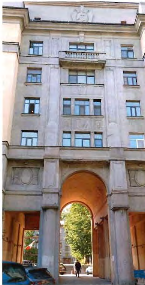
3. Фрагмент. Восточный фасад южного флигеля.
