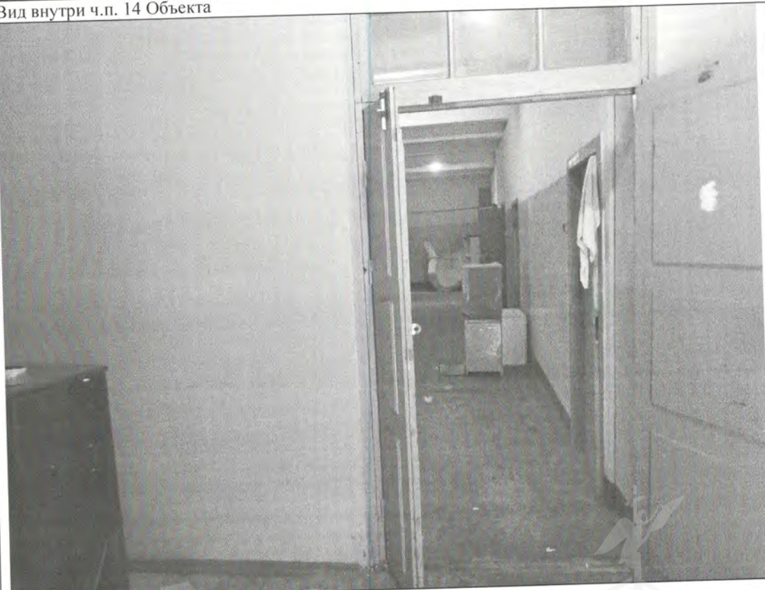
Описание: Между ч.п. 14 и 1 Объекта заложен дверной проем
