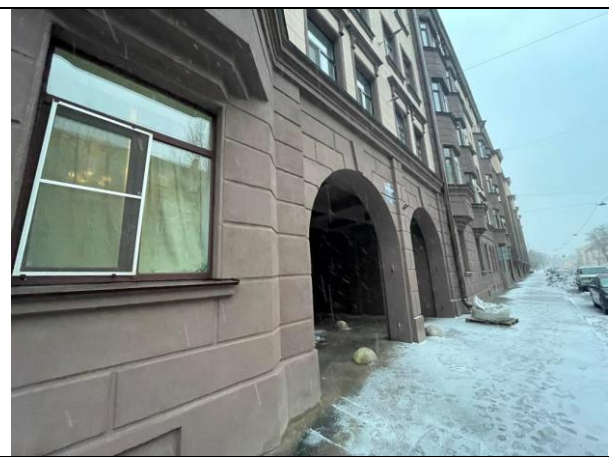
Фото 10. Вид здания расположения Объекта оценки, проход через арку к Объекту оценки (с улицы)
