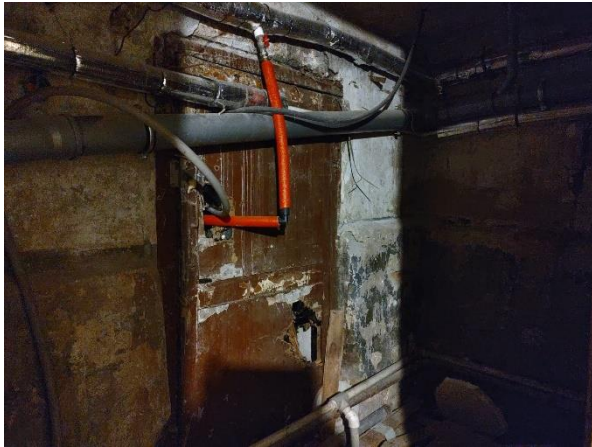
Фото 17. Вход в помещение с ЛК
