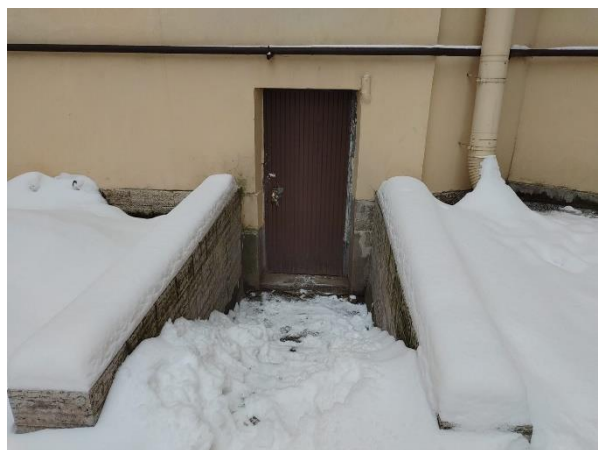
Фото 5. Доступ Объекта оценки (оборудован отдельный вход со двора)
