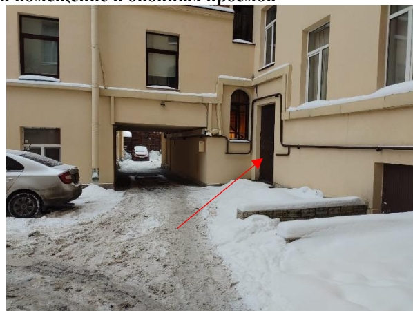
Фото 4. Доступ Объекта оценки. Общий вход со двора
