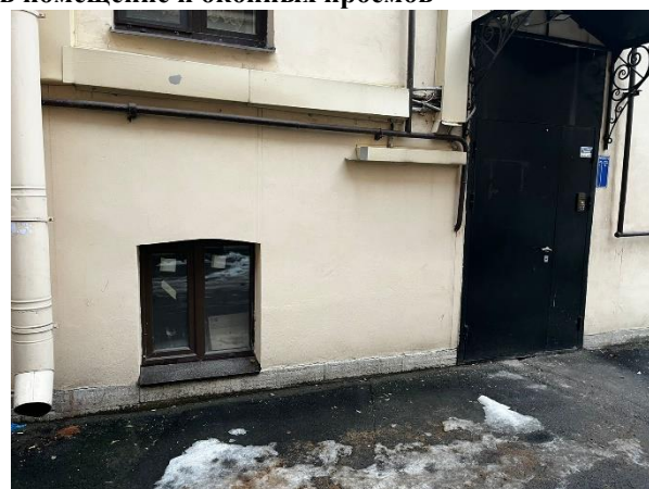
Фото 4. Общий вход со двора и окно Объекта оценки
