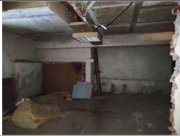
Фото 13. Внутреннее состояние Объекта оценки
