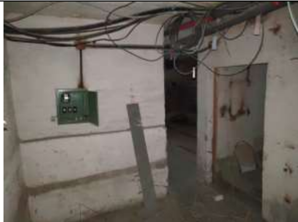
Фото 9. Внутреннее состояние Объекта оценки
