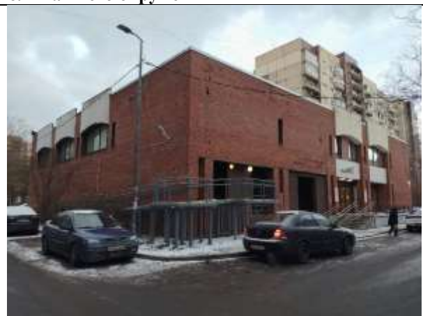
Фото 2. Вид здания, в котором расположен Объект оценки
