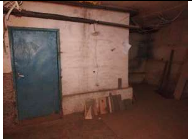
Фото 16. Внутреннее состояние Объекта оценки
