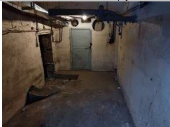
Фото 7. Внутреннее состояние Объекта оценки
