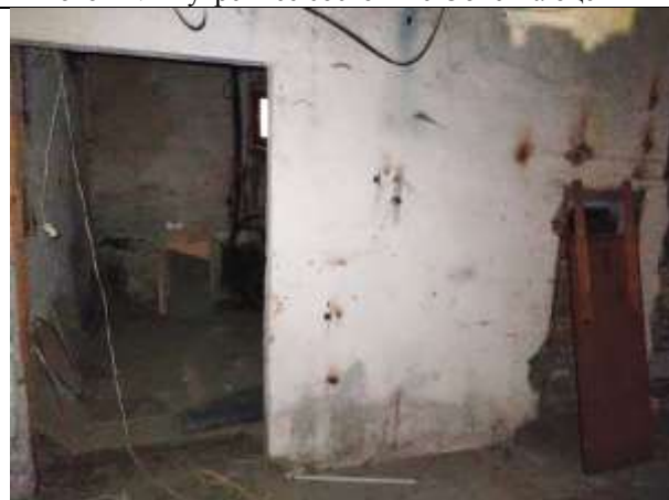
Фото 26. Внутреннее состояние Объекта оценки
