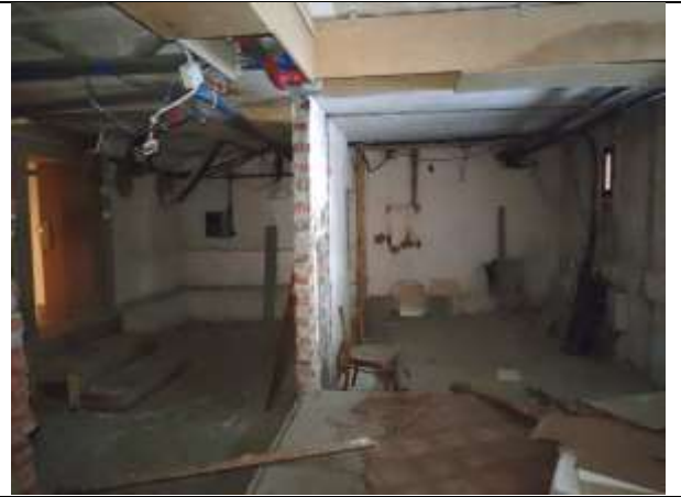
Фото 14. Внутреннее состояние Объекта оценки
