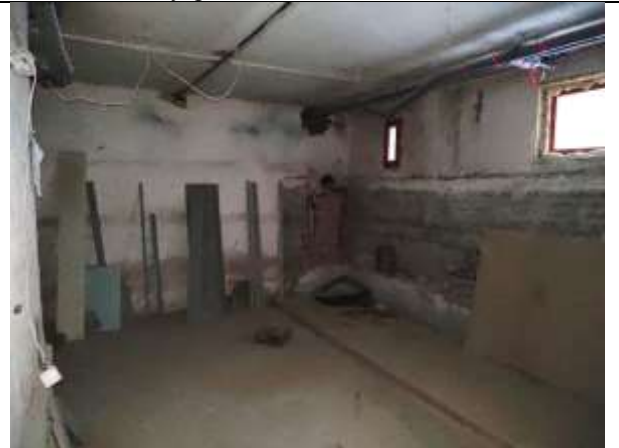
Фото 18. Внутреннее состояние Объекта оценки
