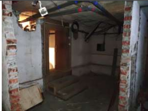
Фото 15. Внутреннее состояние Объекта оценки
