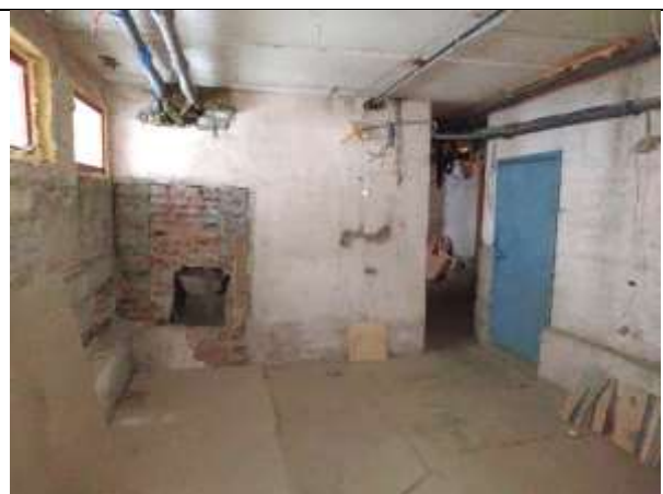
Фото 22. Внутреннее состояние Объекта оценки
