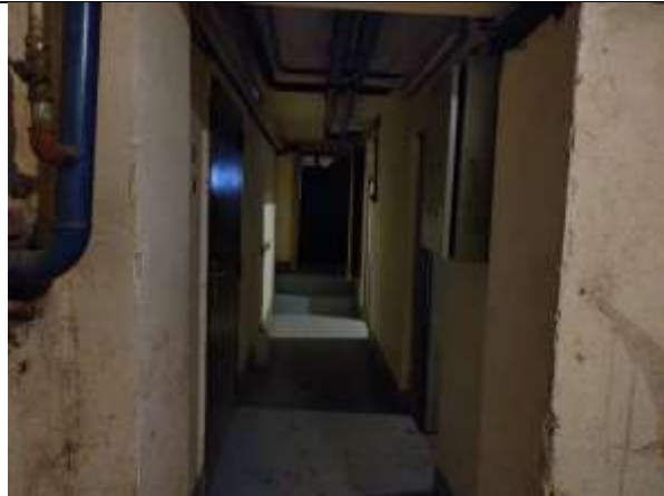
Фото 10. Внутреннее состояние Объекта оценки
