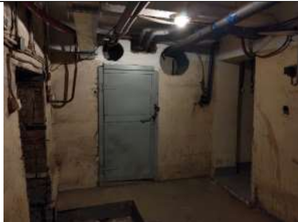
Фото 8. Внутреннее состояние Объекта оценки
