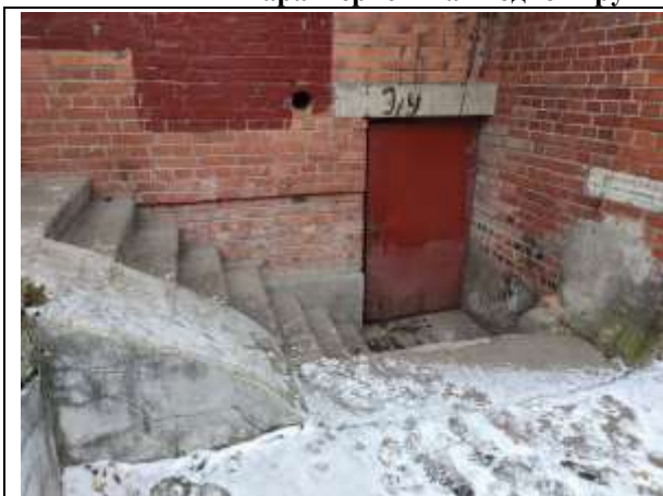
Фото 5. Общий вход со двора
