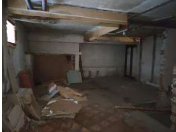
Фото 12. Внутреннее состояние Объекта оценки
