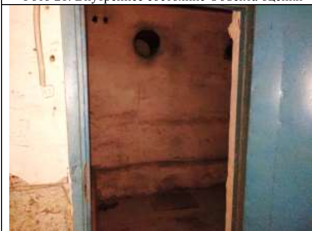
Фото 23. Внутреннее состояние Объекта оценки
