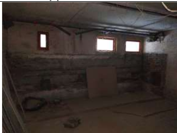
Фото 19. Внутреннее состояние Объекта оценки
