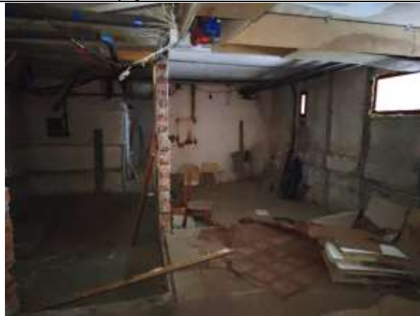
Фото 17. Внутреннее состояние Объекта оценки
