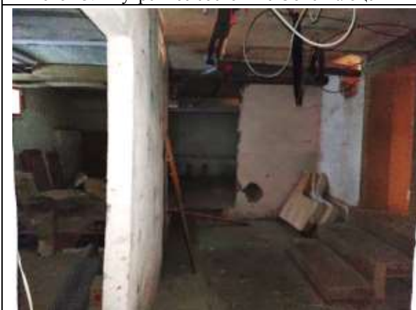
Фото 25. Внутреннее состояние Объекта оценки
