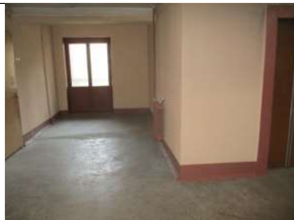
Фото 7. Лестничная клетка 2 этажа
