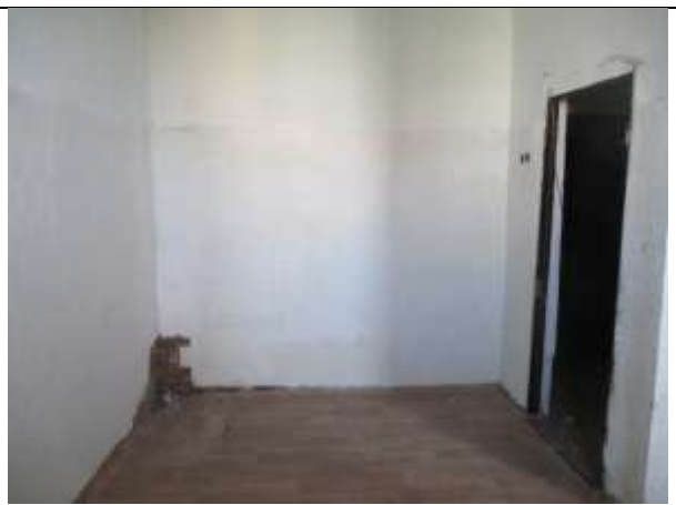
Фото 27. Внутреннее состояние Объекта оценки
