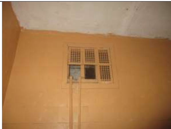
Фото 40. Внутреннее состояние Объекта оценки
