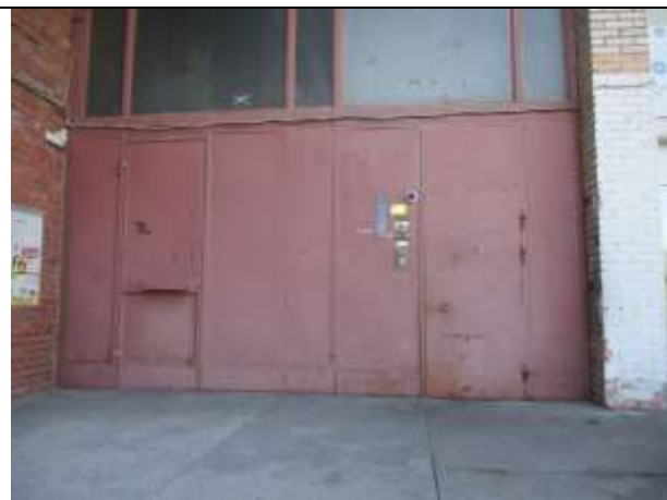
Фото 3. Общий вход со двора
