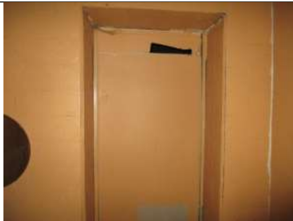
Фото 42. Внутреннее состояние Объекта оценки
