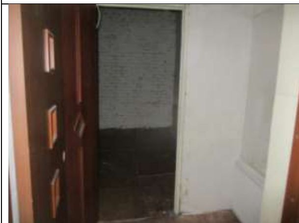
Фото 34. Внутреннее состояние Объекта оценки
