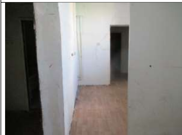
Фото 28. Внутреннее состояние Объекта оценки
