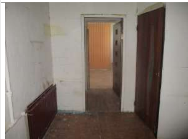
Фото 36. Внутреннее состояние Объекта оценки
