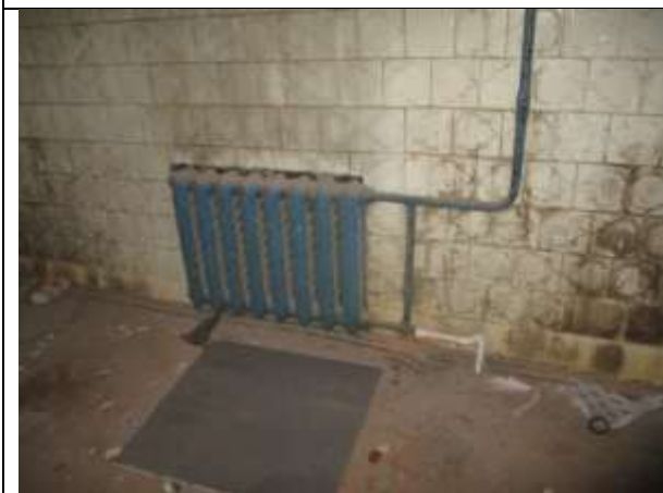
Фото 46. Внутреннее состояние Объекта оценки
