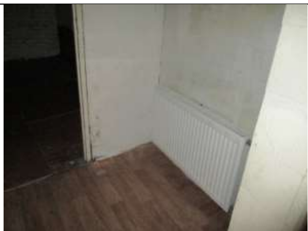
Фото 35. Внутреннее состояние Объекта оценки
