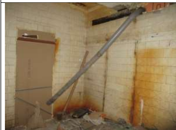
Фото 48. Внутреннее состояние Объекта оценки
