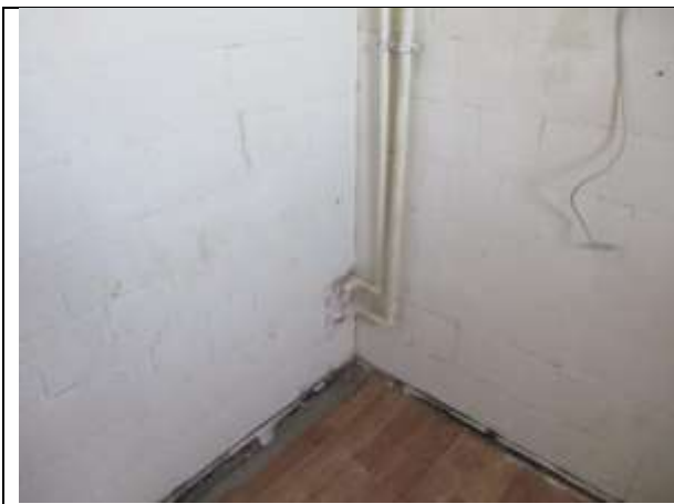
Фото 32. Внутреннее состояние Объекта оценки
