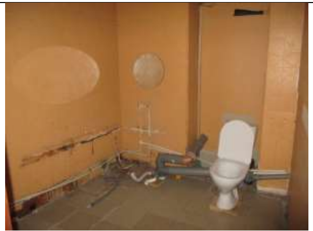
Фото 41. Внутреннее состояние Объекта оценки
