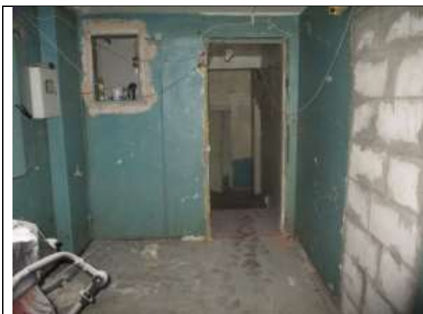
Фото 12. Внутреннее состояние Объекта оценки
