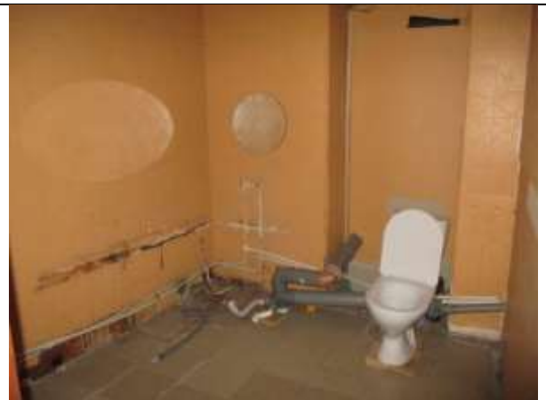
Фото 41. Внутреннее состояние Объекта оценки
