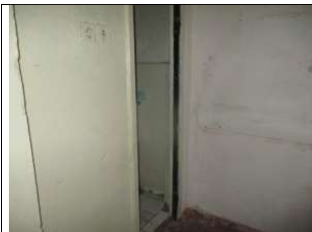
Фото 20. Внутреннее состояние Объекта оценки
