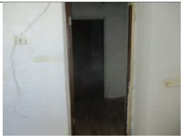
Фото 33. Внутреннее состояние Объекта оценки
