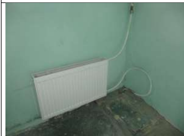
Фото 54. Внутреннее состояние Объекта оценки
