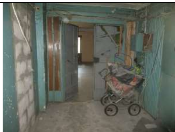
Фото 15. Внутреннее состояние Объекта оценки
