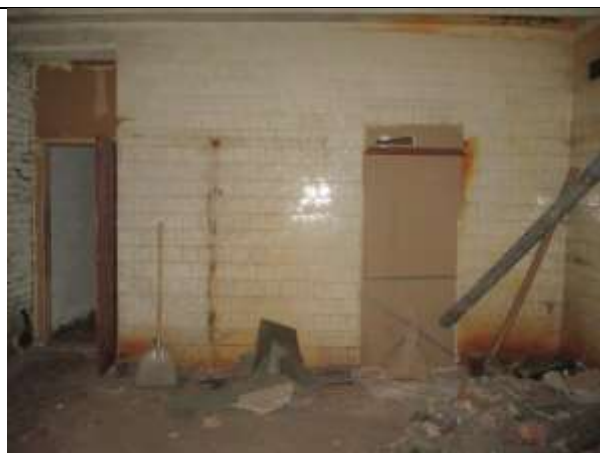
Фото 47. Внутреннее состояние Объекта оценки
