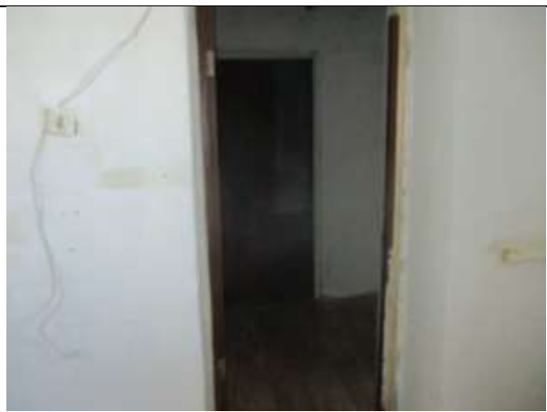
Фото 33. Внутреннее состояние Объекта оценки
