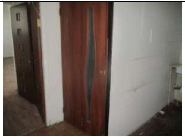
Фото 39. Внутреннее состояние Объекта оценки
