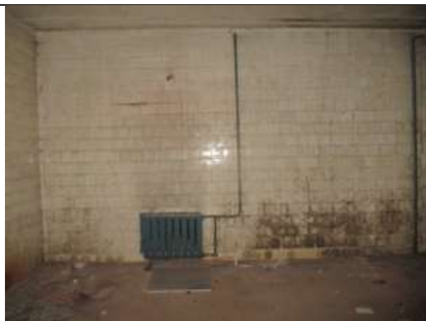
Фото 45. Внутреннее состояние Объекта оценки
