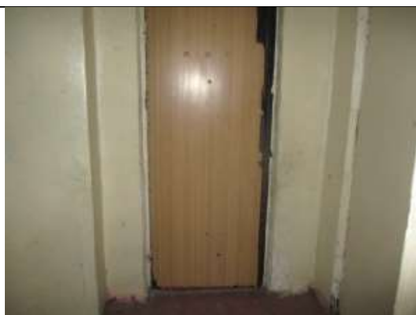
Фото 53. Внутреннее состояние Объекта оценки
