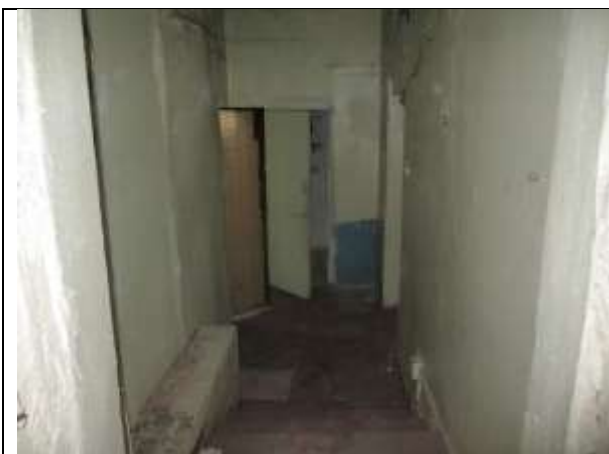
Фото 14. Внутреннее состояние Объекта оценки
