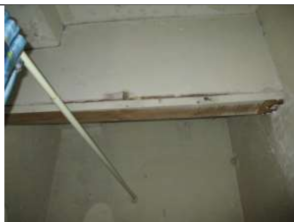
Фото 23. Внутреннее состояние Объекта оценки
