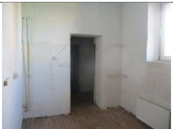
Фото 29. Внутреннее состояние Объекта оценки
