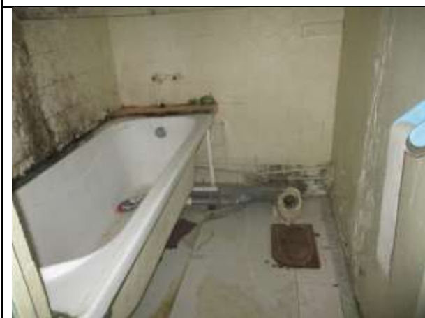
Фото 22. Внутреннее состояние Объекта оценки
