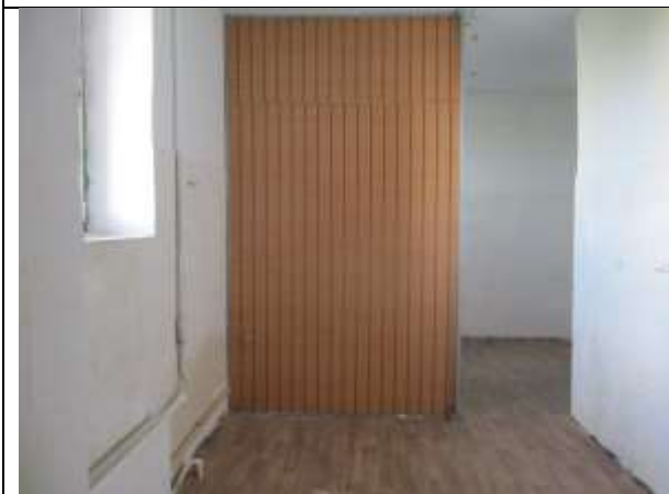
Фото 30. Внутреннее состояние Объекта оценки
