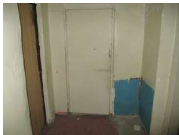
Фото 17. Внутреннее состояние Объекта оценки
