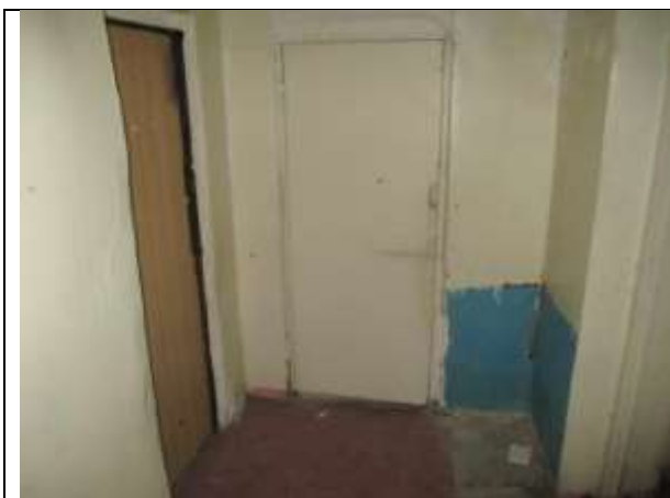
Фото 50. Внутреннее состояние Объекта оценки
