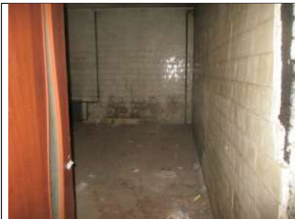
Фото 44. Внутреннее состояние Объекта оценки
