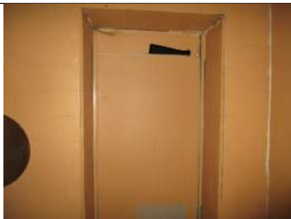
Фото 42. Внутреннее состояние Объекта оценки
