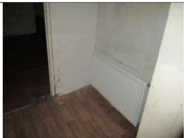
Фото 35. Внутреннее состояние Объекта оценки
