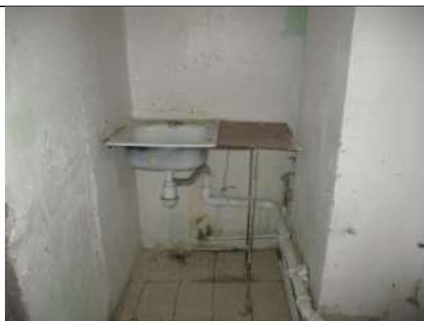
Фото 51. Внутреннее состояние Объекта оценки
