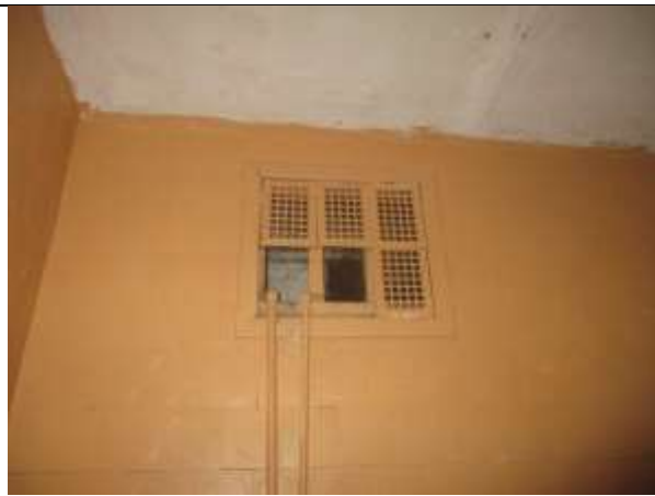
Фото 40. Внутреннее состояние Объекта оценки
