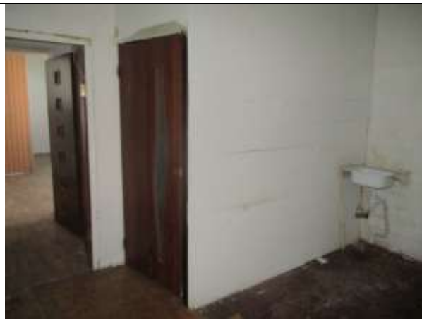
Фото 38. Внутреннее состояние Объекта оценки
