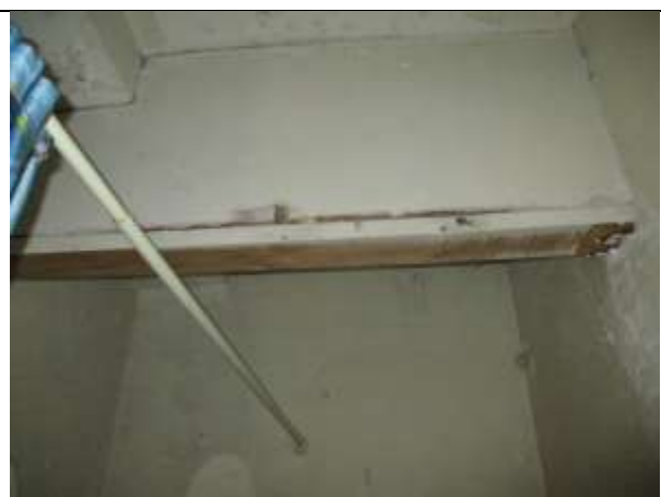
Фото 23. Внутреннее состояние Объекта оценки
