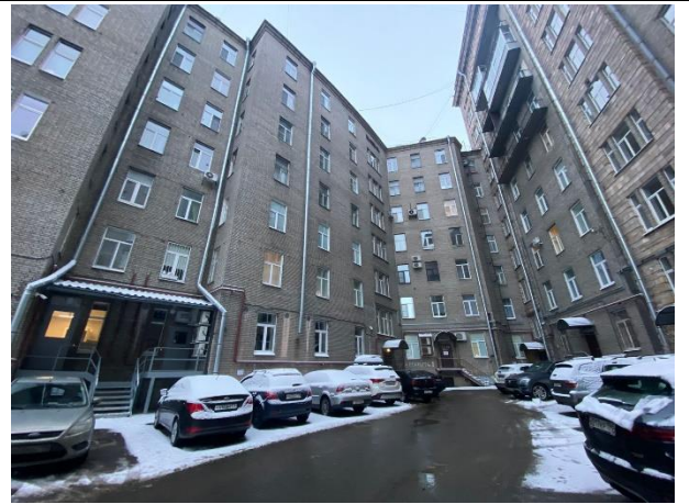
Фото 6 Фасад здания со двора
